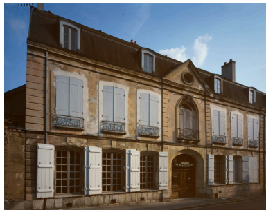
Vue d'ensemble depuis la rue. Phot. Thierry Lefébure IVR22_19940201016VA
