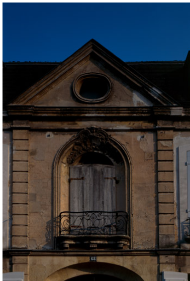
La travée médiane de la façade sur rue. Phot. Thierry Lefébure IVR22_19940201022XA
