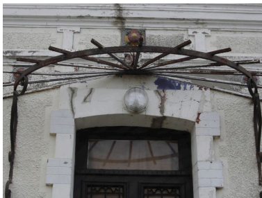
Vue détaillée de la marquise. Phot. Inès Guérin IVR22_20068005162NUCA
