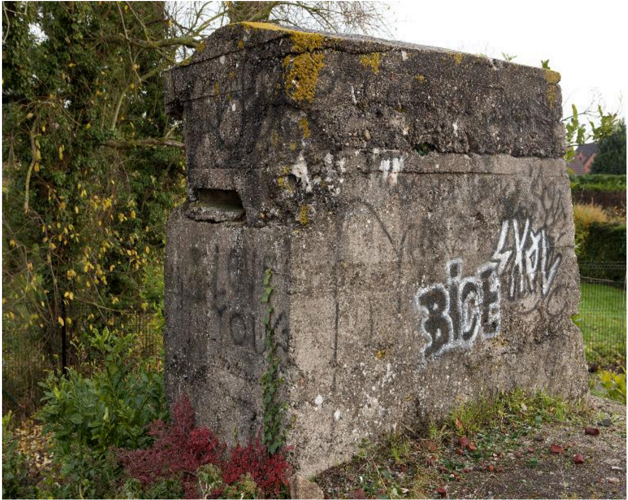
Depuis le couverture, la tourelle d'observation (au grand angulaire)
