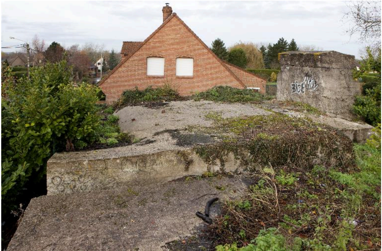
Depuis le couvrement, vue générale vers le nord (au grand angulaire)
