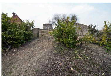
Vue générale, vers le nord (au grand angulaire) Phot. Jean-Marc Ramette IVR31_20145904373NUCA
