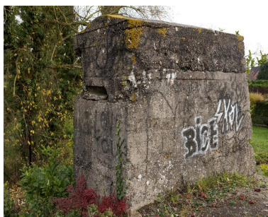
Depuis le couvrement, la tourelle d'observation (au grand angulaire) Phot. Jean-Marc Ramette IVR31_20145904366NUCA
