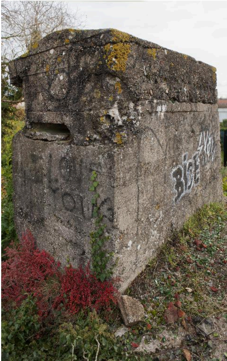
Depuis le couverture, la tourelle d'observation (au grand angulaire)
