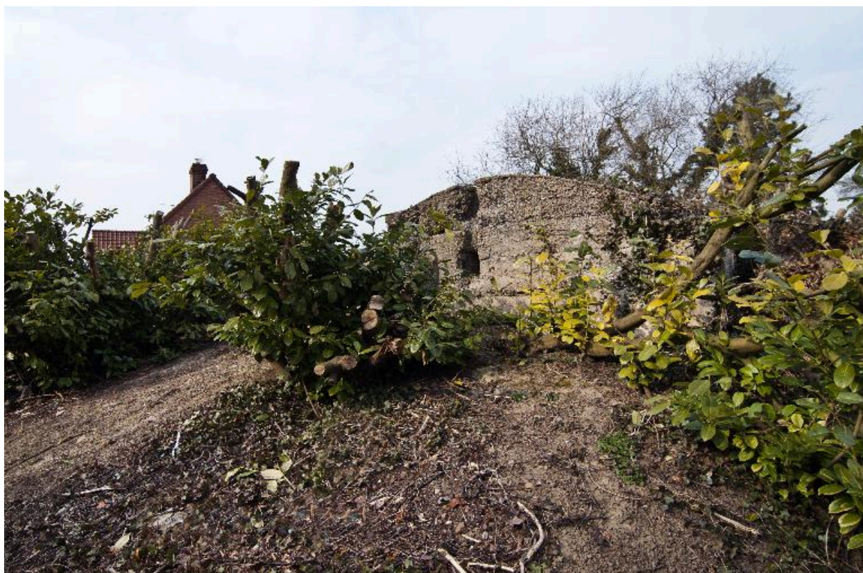
Elévation sud, détail (au grand angulaire)
