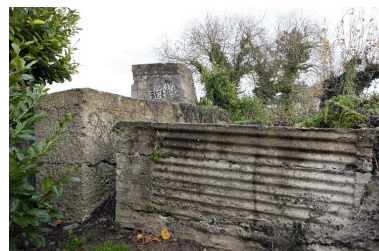
Elévation sud (au grand angulaire) Phot. Jean-Marc Ramette IVR31_20145904369NUCA
