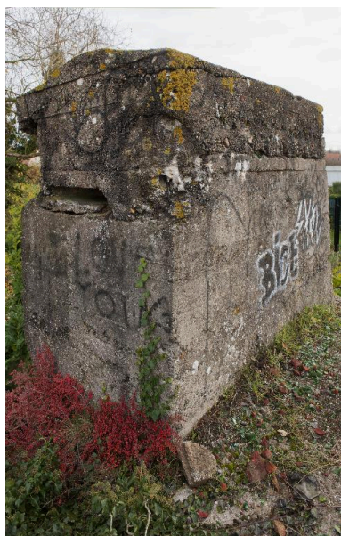
Depuis le couvrement, la tourelle d'observation (au grand angulaire) Phot. Jean-Marc Ramette IVR31_20145904367NUCA
