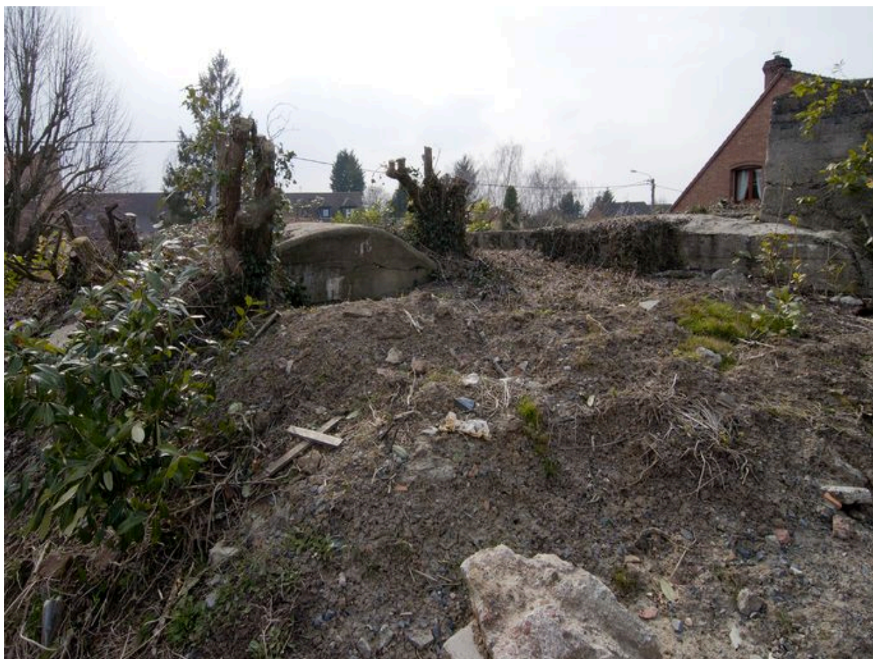
Vue générale, vers l'ouest (au grand angulaire)
