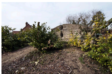
Elévation sud, détail (au grand angulaire) Phot. Jean-Marc Ramette IVR31_20145904376NUCA
