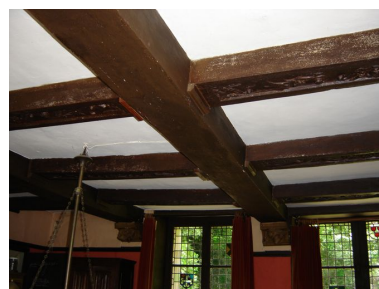
Vue du plafond d'une salle 16 e siècle. Phot. Inès Guérin IVR22_20058005733NUCA
