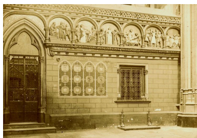
Vue des vantaux de la porte latérale sud du choeur, vers 1900 (Société académique de Saint-Quentin : non coté). Phot. Riboulleau Christiane IVR22_20100201012NUCA
