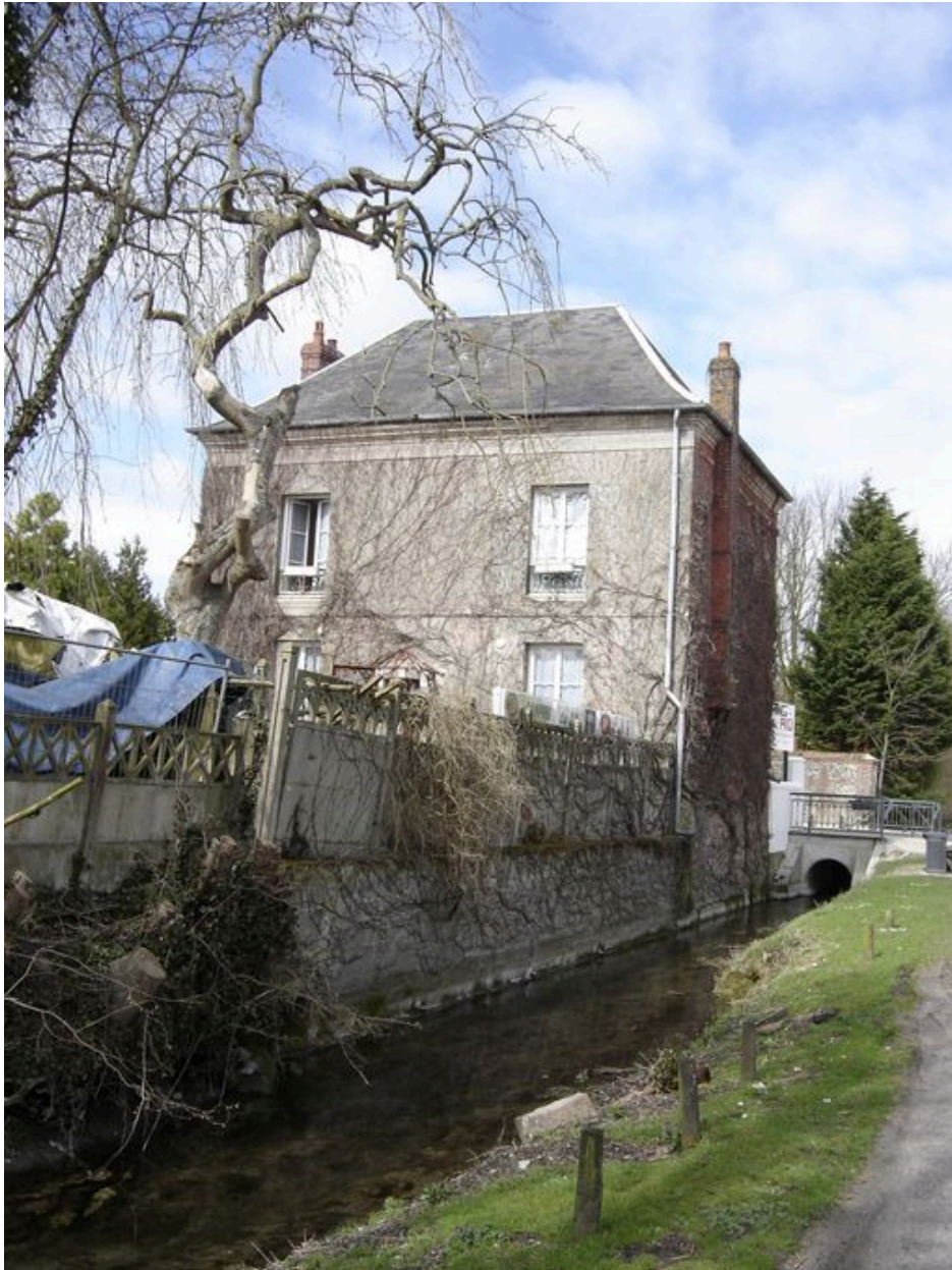
Vue postérieure du logis longé par le rû.
