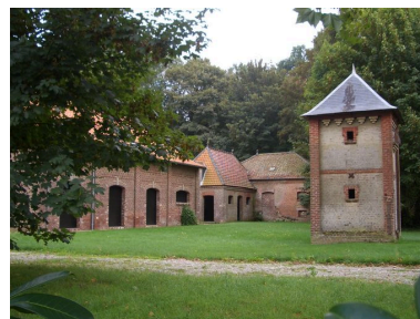
Vue générale des bâtiments agricoles. Phot. Inès Guérin IVR22_20078005094NUCA
