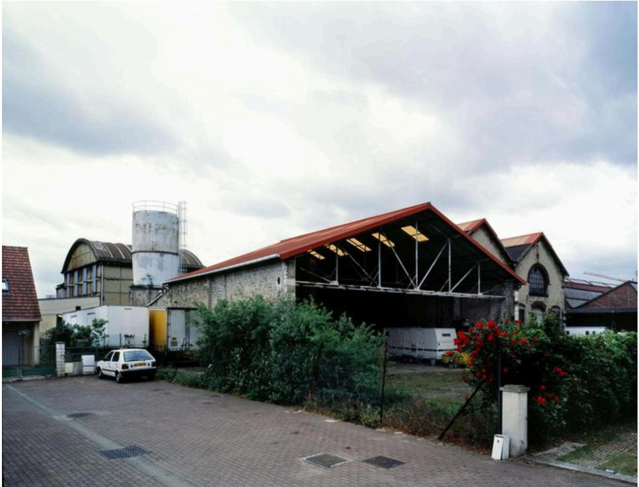
Vue vers le sud des bâtiments construits dans la décennie 1880 (au premier plan) et du réservoir d'eau utilisé pour le refroidissement des machines de la tréfilerie (à l'arrière-plan).
