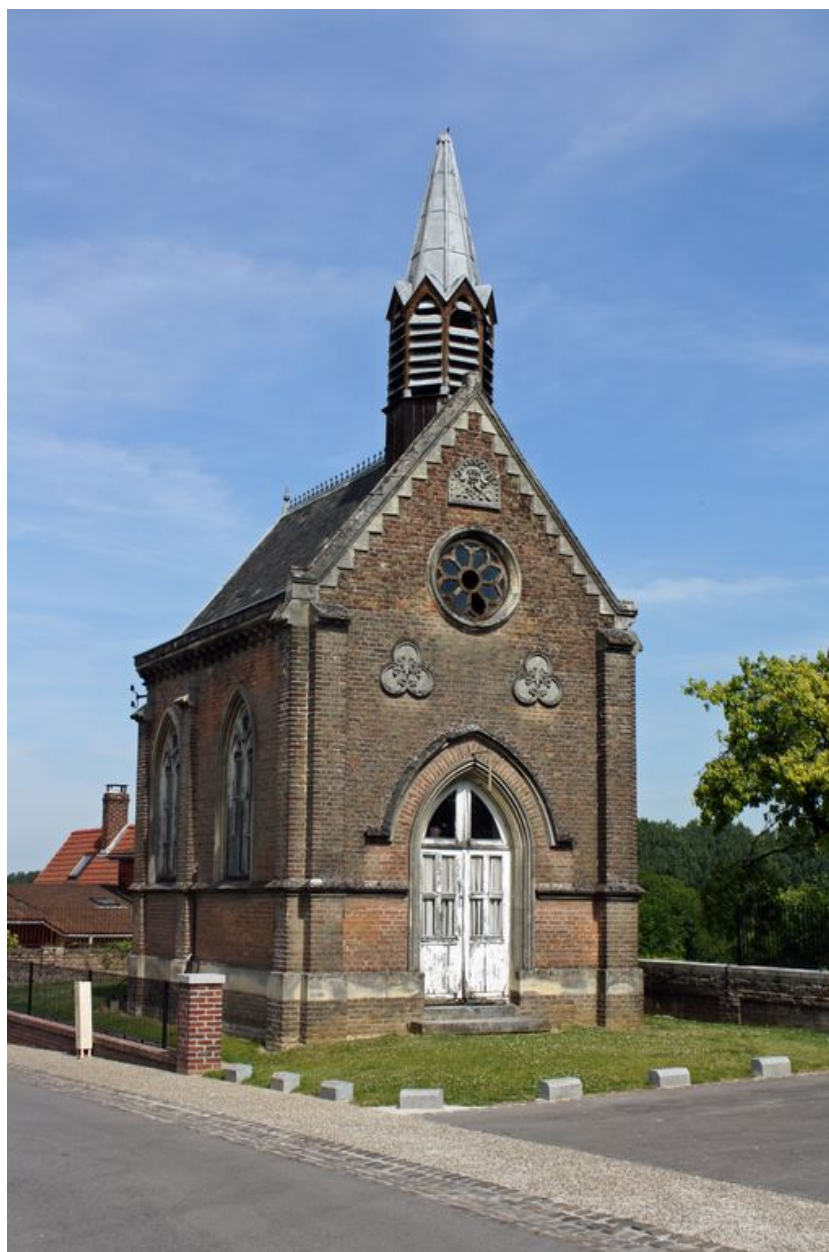
Ville-le-Marlet, chapelle Saint-Lambert, Jean Herbault architecte (?), 1868.
