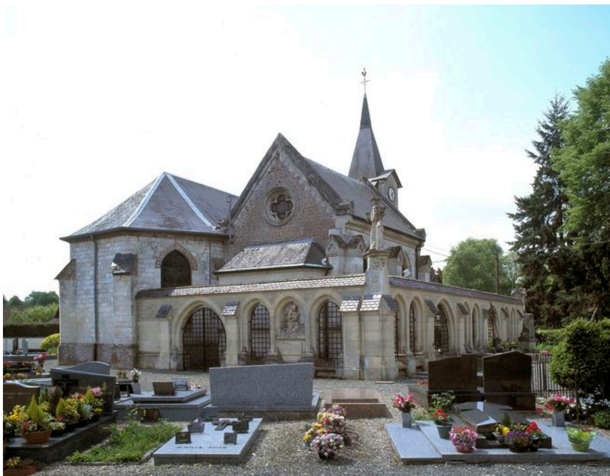
Ribeaucourt, clôture de l'enclos de la chapelle funéraire de la famille de Berny, Pierre et Gérard Ansart architectes et décorateurs, 1937.
