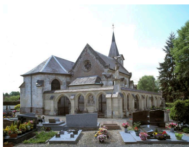
Ribeaucourt, clôture de l'enclos de la chapelle funéraire de la famille de Berny, Pierre et Gérard Ansart architectes et décorateurs, 1937. Phot. Marie-Laure Monnehay-Vulliet IVR22_20108000155XA
