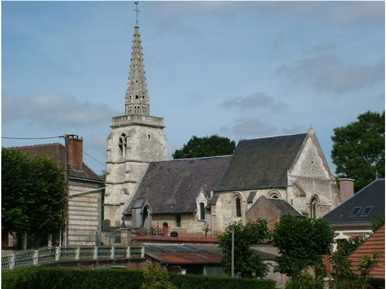
Bouchon, église paroissiale Saint-Pierre, 13e siècle (choeur et tour-clocher), 16e siècle (nef), et 1631 (flèche, Daullé architecte).
