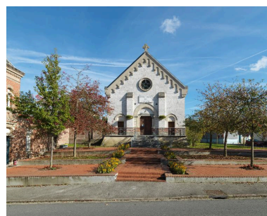
Saint-Ouen, église paroissiale Saint-Ouen, Charles Demoulins architecte, 1824 et 1844. Phot. Thierry Lefébure IVR22_20128001015NUC2A
