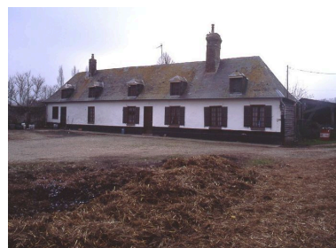
Vue du logis sur le côté occidental de la cour. Phot. Irwin Leullier IVR22_20078000082XA
