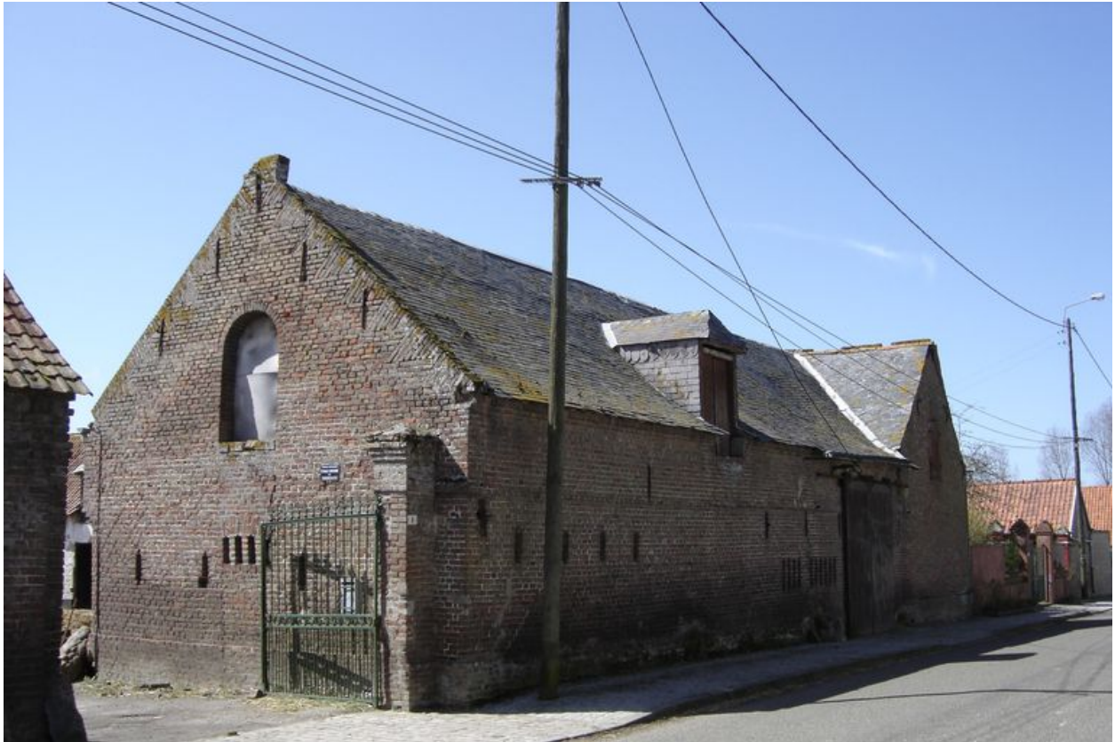
Vue de la bergerie depuis la rue.
