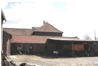
Vue des porcheries à boxes indépendants. Phot. Inès Guérin IVR22_20058005534NUCA
