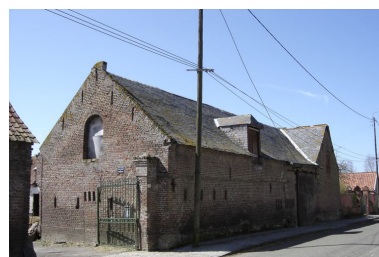
Vue de la bergerie depuis la rue. Phot. Inès Guérin IVR22_20058005530NUCA
