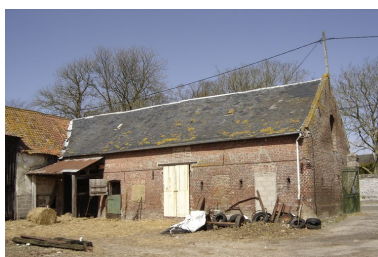
Vue de la bergerie. Phot. Inès Guérin IVR22_20058005529NUCA
