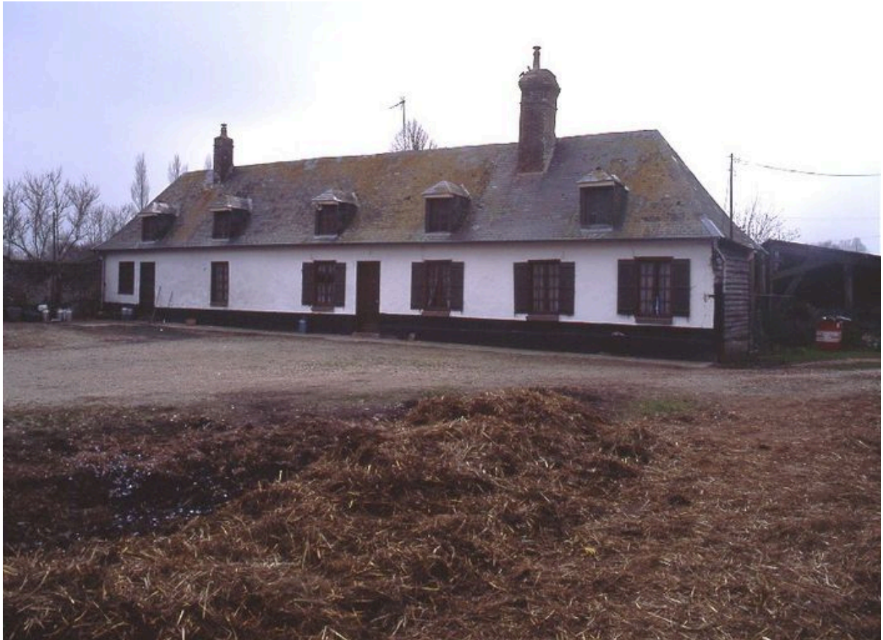
Vue du logis sur le côté occidental de la cour.
