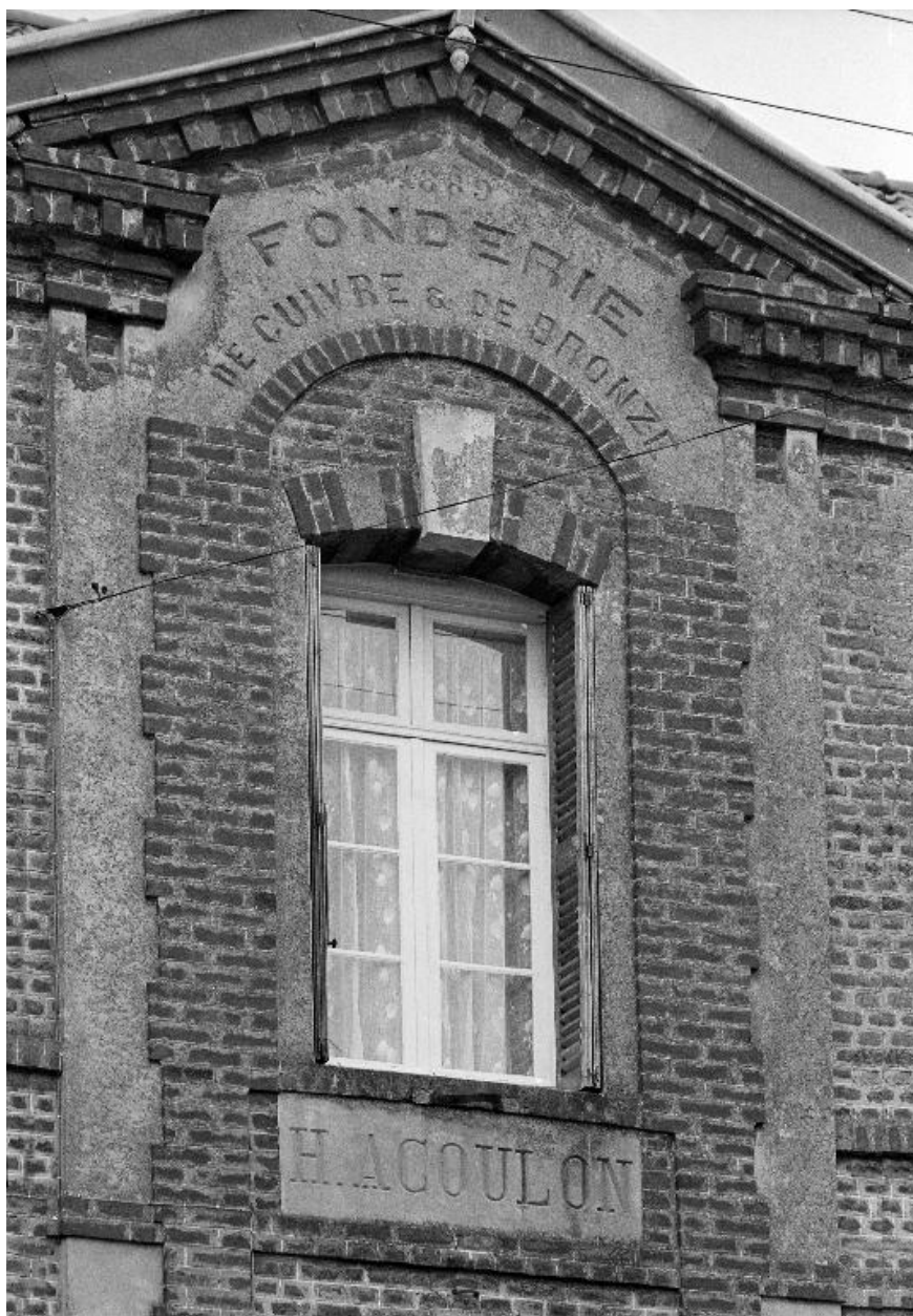
Logement patronal, détail, en 1990.
