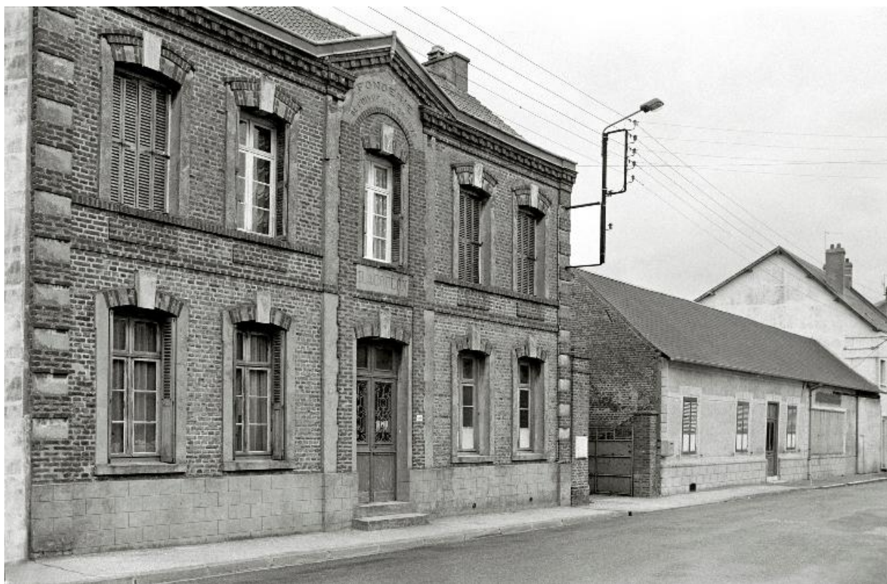
Vue d'ensemble depuis la rue Isaïe-Sellier, en 1990.
