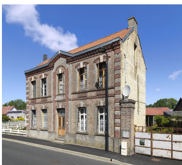
Ancien logement patronal. Phot. Thierry Lefébure IVR22_20158000383NUC2A
