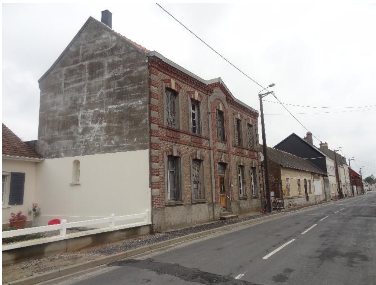
Vue d'ensemble depuis la rue Isaïe-Sellier.
