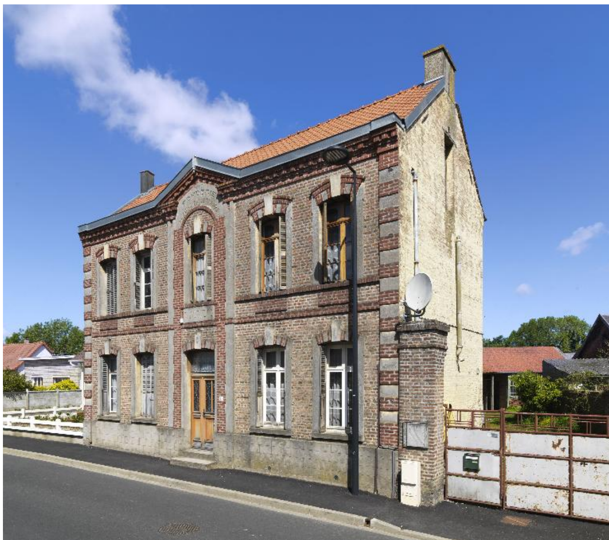
Ancien logement patronal.
