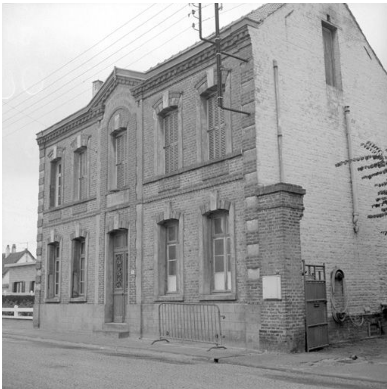
Logement patronal, élévation antérieure.
