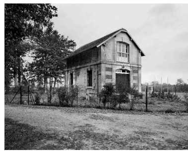
La conciergerie, vue depuis l'est. Phot. Thierry Lefébure IVR22_19900201984V
