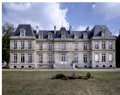
Vue de la façade occidentale. Phot. Thierry Lefébure IVR22_19900202423VA
