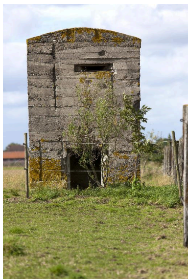
Vue frontale, vers le nord-ouest Phot. Jean-Marc Ramette IVR31_20145904235NUCA
