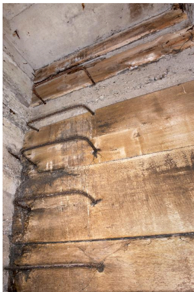
Vue intérieure : échelons métalliques et coffrage Phot. Pierre Thibaut IVR32_20165900570NUCA
