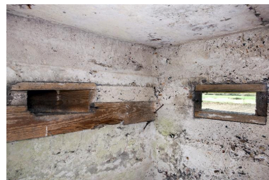
Vue intérieure : ébrasures d'observation Phot. Pierre Thibaut IVR32_20165900571NUCA
