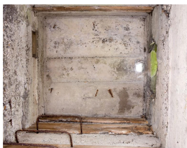
Vue intérieure zénithale Phot. Pierre Thibaut IVR32_20165900569NUCA
