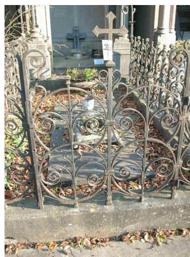
Vue du portillon. Phot. Laurent Nicolas IVR22_20048001287NUCA
