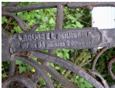
Signature du serrurier sur la clôture. Phot. Isabelle Barbedor IVR22_20058002296NUCA
