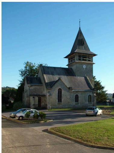
Vue générale depuis le nord. Phot. Irwin Leullier IVR22_20050201087NUCA
