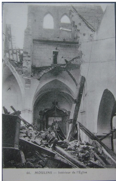
Intérieur de l'ancienne église en ruines (coll. part.). Phot. Inès Guérin
