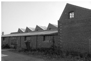
Atelier de fabrication, flanc ouest, vue partielle Phot. Francis Dubuc IVR22_19908001288Z
