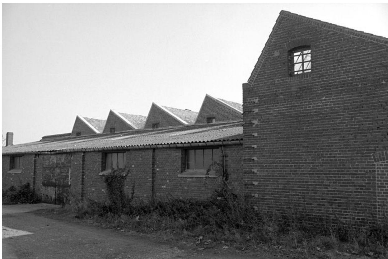
Atelier de fabrication, flanc ouest, vue partielle
