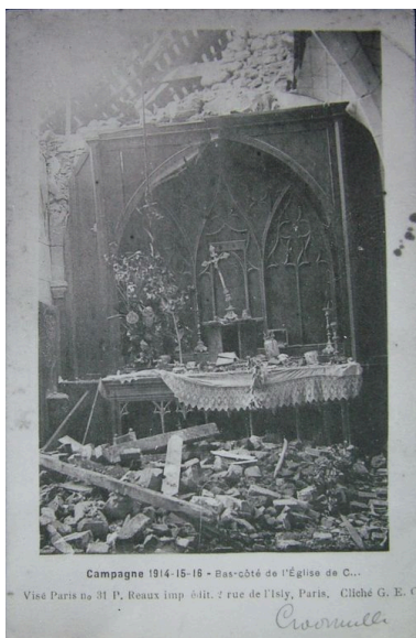
Vue de l'autel du collatéral nord pendant les conflits (coll. part). Phot. Inès Guérin IVR22_20050200681NUCAB
