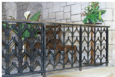
Vue de la grille de chœur. Phot. Irwin Leullier IVR22_20050200846NUCA
