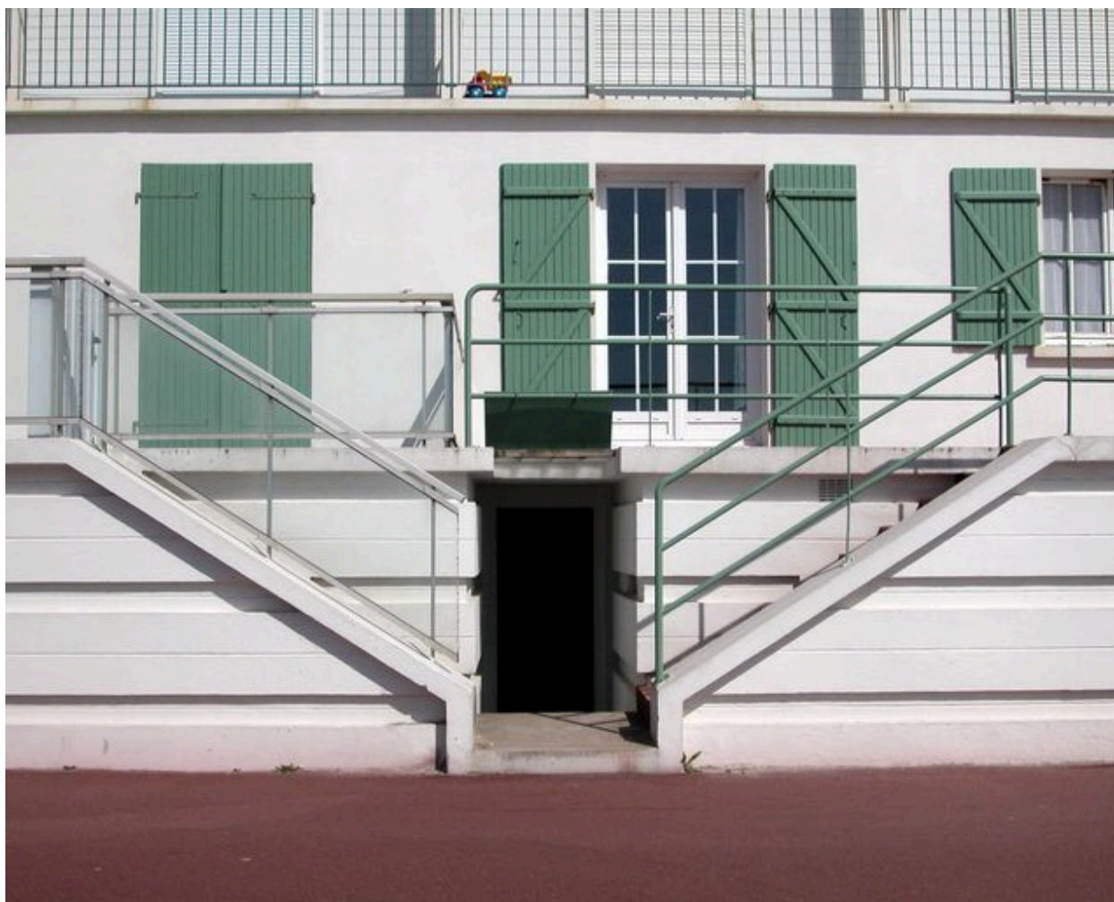
200 boulevard maritime sud (Ma Cazotte), détail du soubassement de la façade sur mer.
