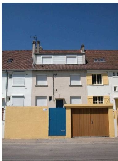
230 boulevard maritime sud, façade d'entrée. Phot. Elisabeth Justome IVR22_20058003866NUCA
