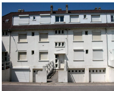
154 boulevard maritime sud (Océano Nox), façade d'entrée. Phot. Elisabeth Justome IVR22_20058003851NUCA
