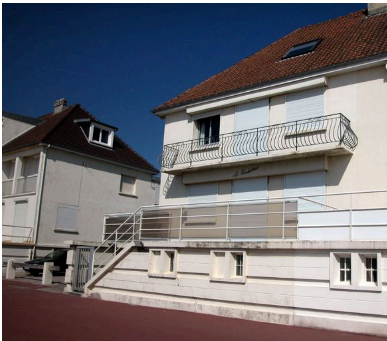
182 boulevard maritime sud (Les Scalaires), façade sur mer.
