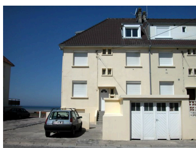
324 boulevard maritime sud, façade d'entrée. Phot. Elisabeth Justome IVR22_20058003890NUCA
