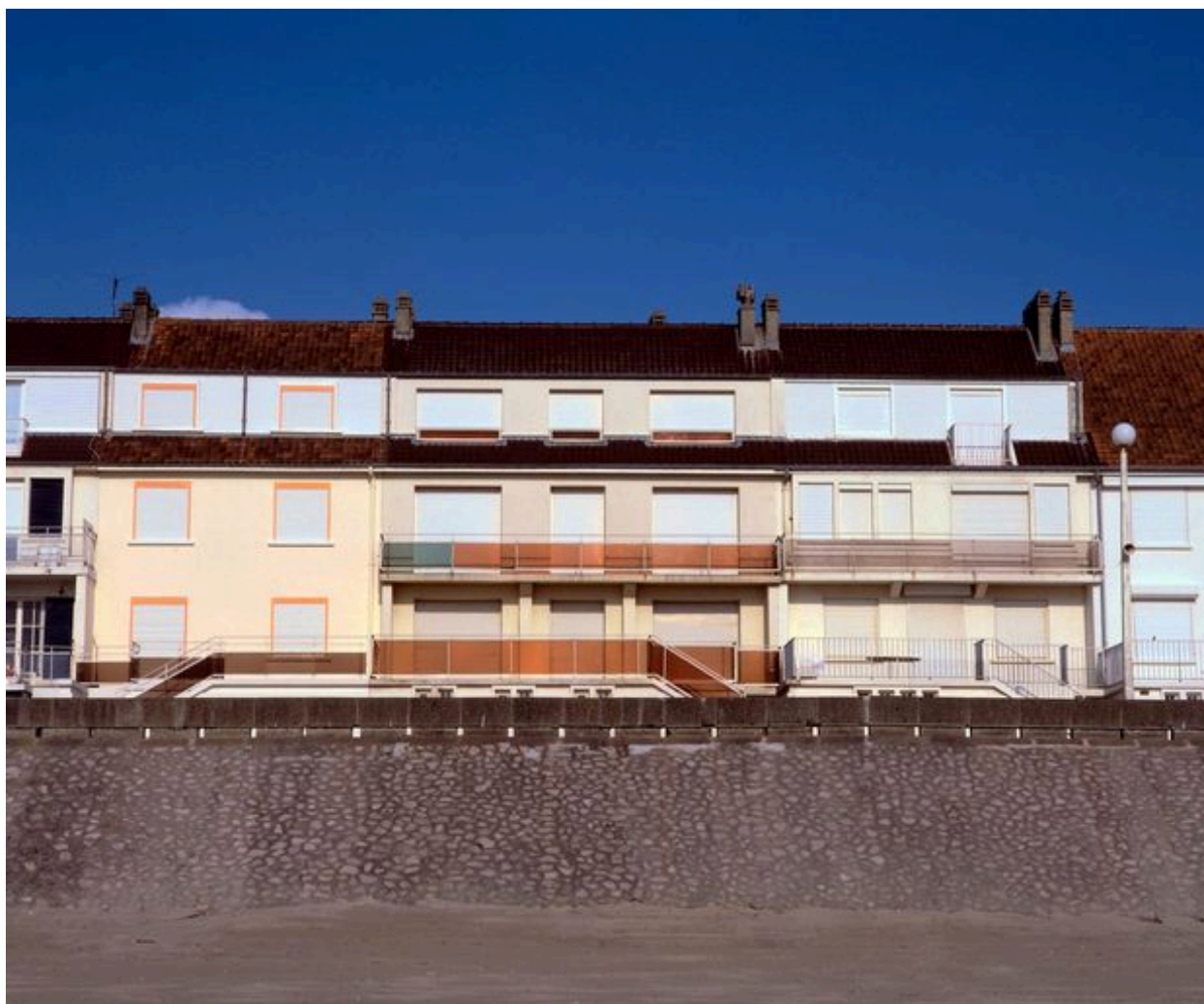
Détail de trois maisons.
