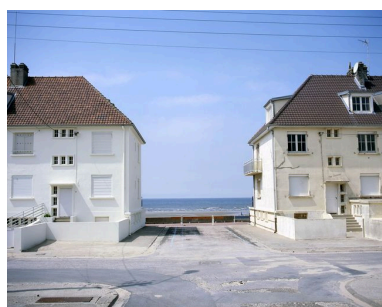
Percée vers la mer, entre deux îlots Phot. Marie-Laure Monnehay-Vulliet IVR22_20048000071XA
