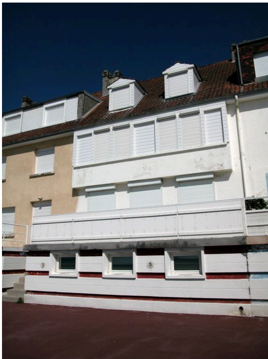
236 boulevard maritime sud (Véga), façade sur mer.
