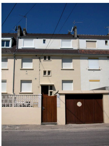
316 boulevard maritime sud, façade d'entrée. Phot. Elisabeth Justome IVR22_20058003888NUCA
