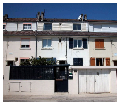
260 boulevard maritime sud (Doris), façade d'entrée. Phot. Elisabeth Justome IVR22_20058003874NUCA
