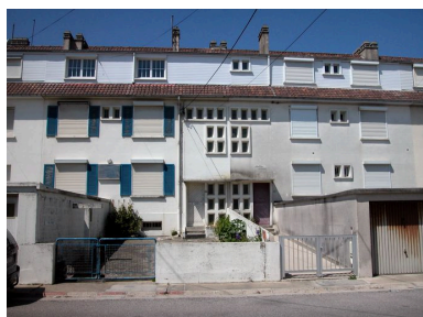
68 et 72 boulevard maritime sud (Victoire et Stella Maris), façade d'entrée. Phot. Elisabeth Justome IVR22_20058003833NUCA
