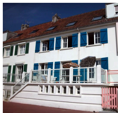
110 boulevard maritime sud (Les Tamaris), façade sur mer. Phot. Elisabeth Justome IVR22_20058003841NUCA
