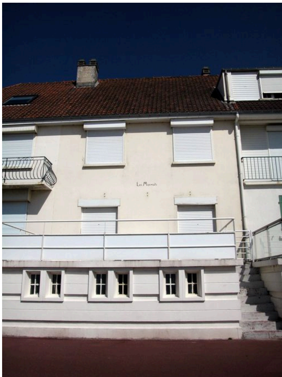
188 boulevard maritime sud (Les Marmots), façade sur mer.
