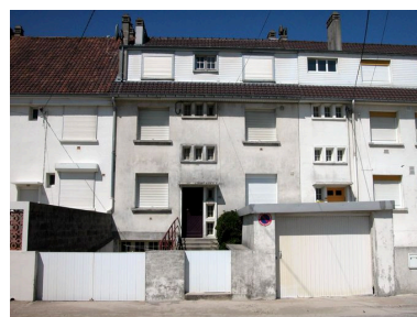
286 boulevard maritime sud, façade d'entrée. Phot. Elisabeth Justome IVR22_20058003880NUCA
