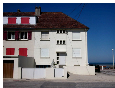
342 boulevard maritime sud, façade d'entrée. Phot. Elisabeth Justome IVR22_20058003892NUCA
