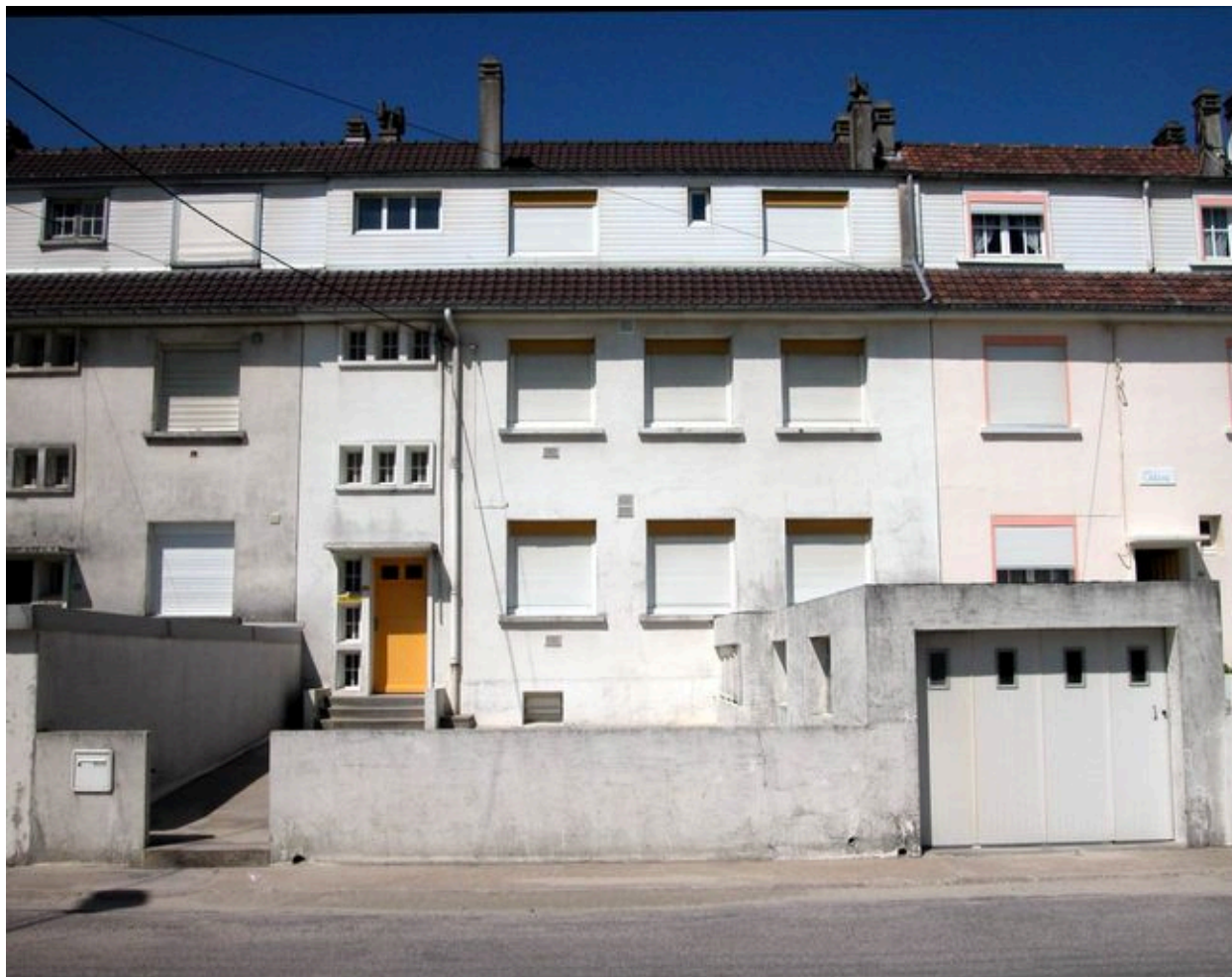
280 boulevard maritime sud (Calypso), façade d'entrée.
