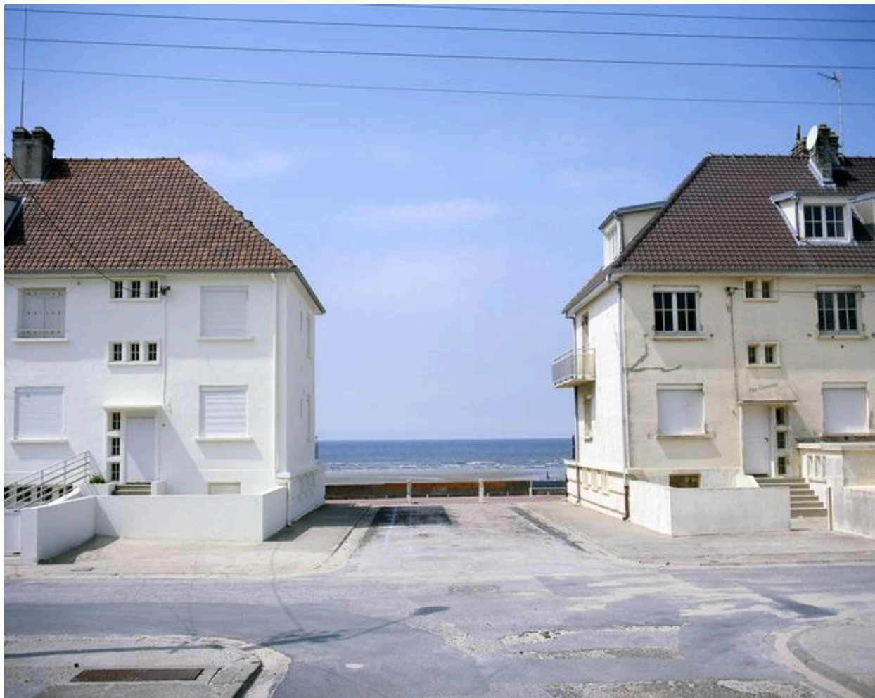
Percée vers la mer, entre deux îlots
