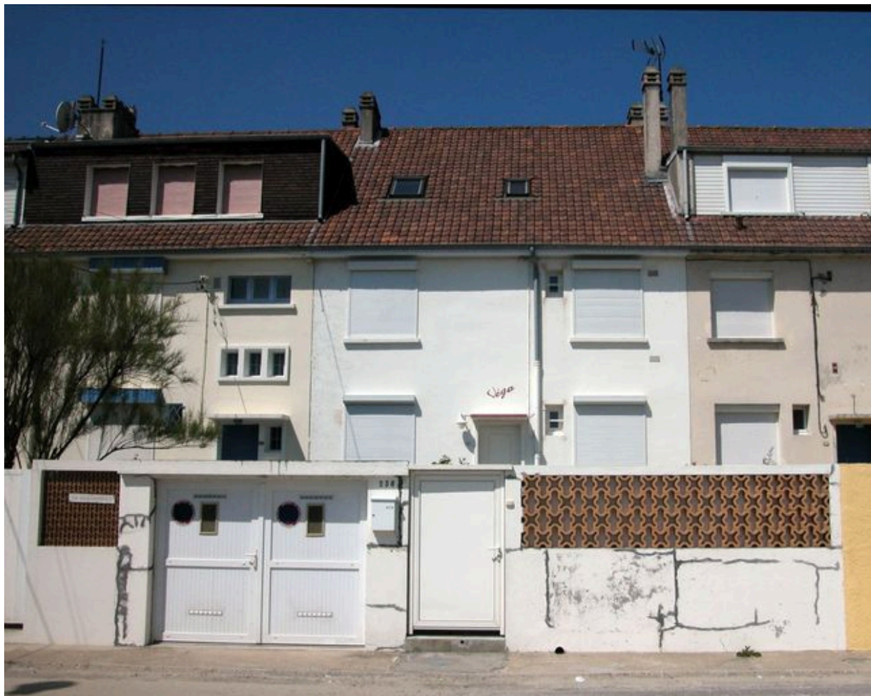
236 boulevard maritime sud (Véga), façade d'entrée.
