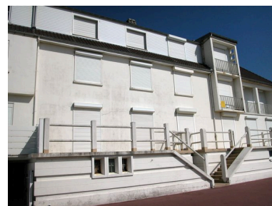
154 boulevard maritime sud (Océano Nox), façade sur mer. Phot. Elisabeth Justome IVR22_20058003850NUCA
