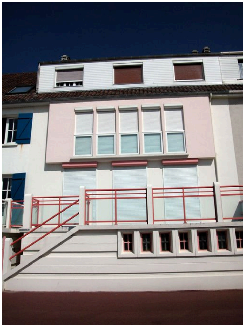
116 boulevard maritime sud (Hurlevent), façade sur mer.
