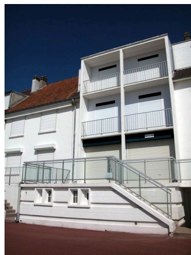
300 boulevard maritime sud (Face au Large), façade sur mer. Phot. Elisabeth Justome IVR22_20058003883NUCA
