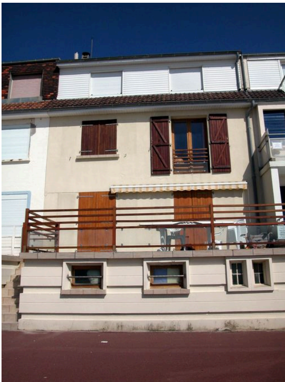
252 boulevard maritime sud (L'Hirondelle de Mer), façade sur mer.
