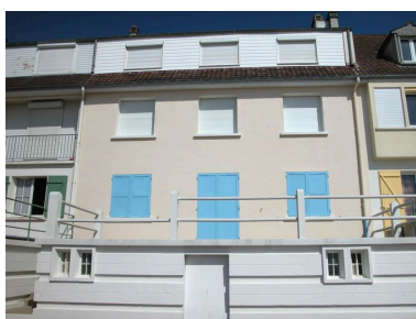
210 boulevard maritime sud (Les Alouettes), façade sur mer. Phot. Elisabeth Justome IVR22_20058003861NUCA
