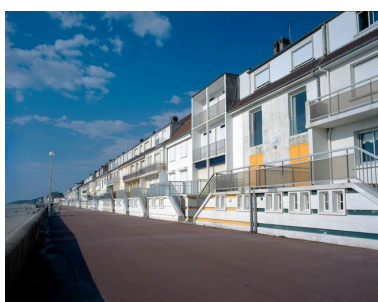
Vue d'ensemble depuis la digue, vers le nord. Phot. Marie-Laure Monnehay-Vulliet IVR22_20038000494XA
