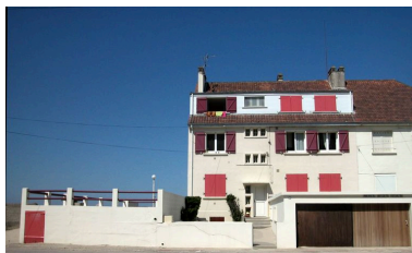
352 boulevard maritime sud, façade d'entrée. Phot. Elisabeth Justome IVR22_20058003894NUCA
