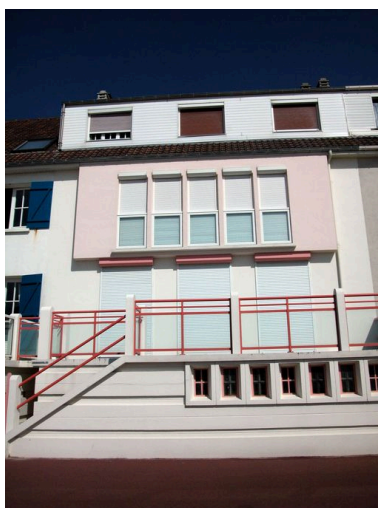
116 boulevard maritime sud (Hurlevent), façade sur mer. Phot. Elisabeth Justome IVR22_20058003843NUCA
