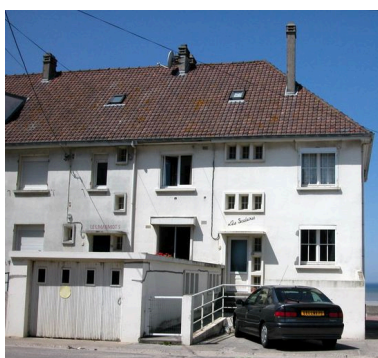
182 boulevard maritime sud (Les Scalaires), façade d'entrée. Phot. Elisabeth Justome IVR22_20058003855NUCA
