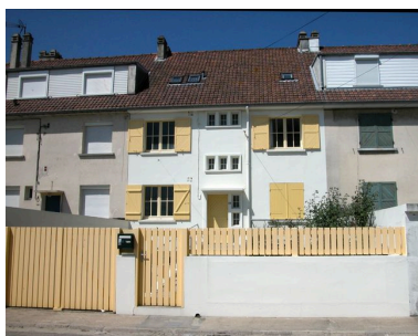
222 boulevard maritime sud, façade d'entrée. Phot. Elisabeth Justome IVR22_20058003864NUCA
