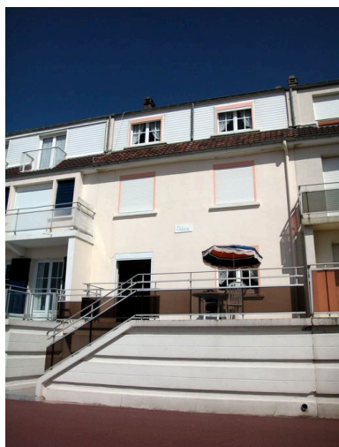
268 boulevard maritime sud (Océane), façade sur mer. Phot. Elisabeth Justome IVR22_20058003875NUCA
