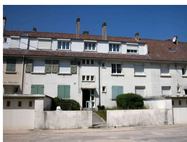
200 boulevard maritime sud (Ma Cazotte), façade d'entrée. Phot. Elisabeth Justome IVR22_20058003860NUCA
