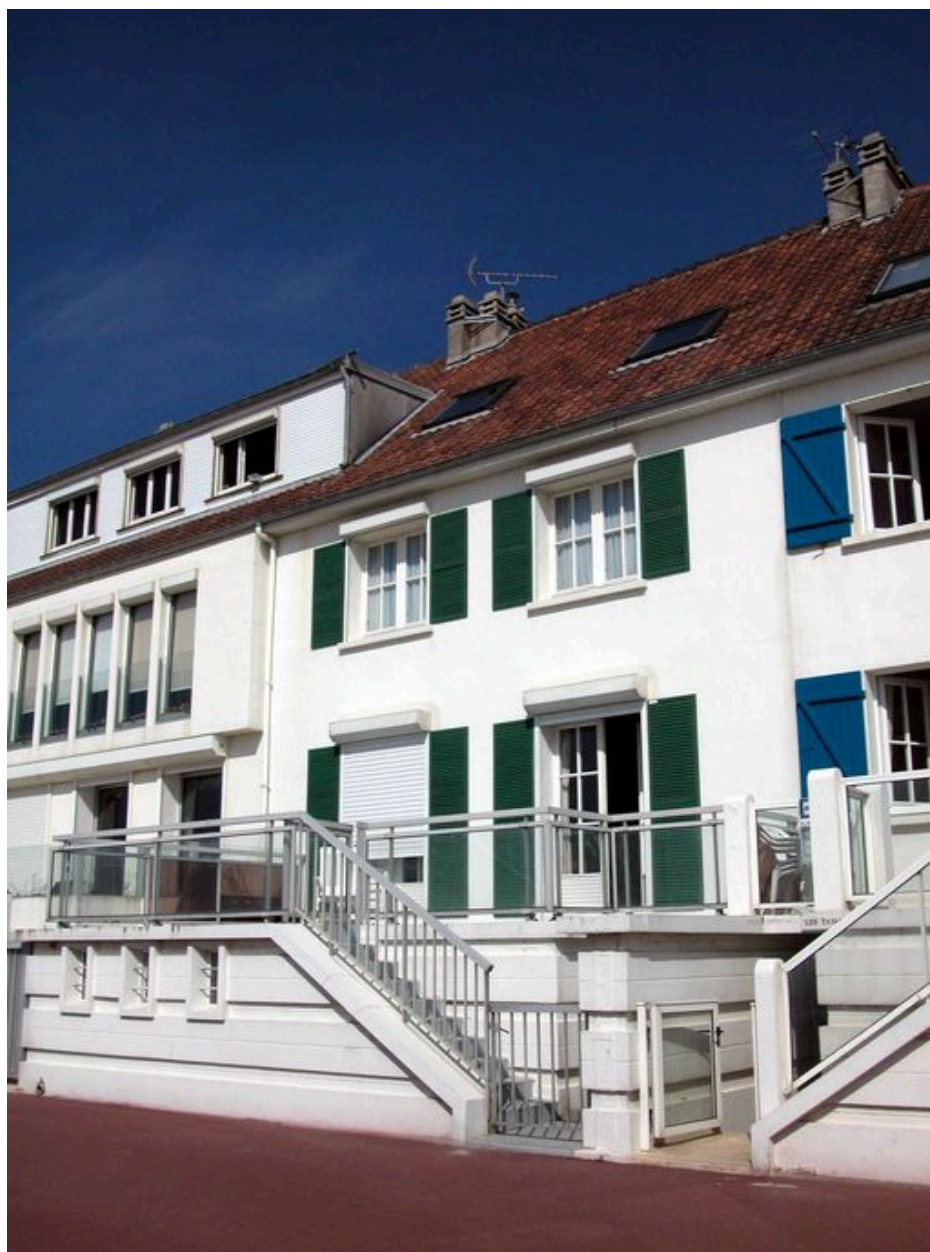
102 boulevard maritime sud (Faraon), façade sur mer.
