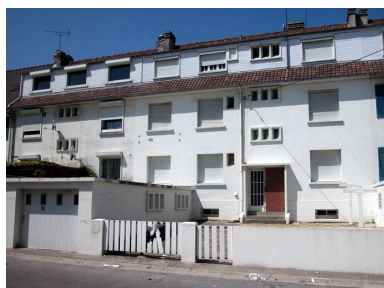
84 boulevard maritime sud, façade d'entrée. Phot. Elisabeth Justome IVR22_20058003836NUCA
