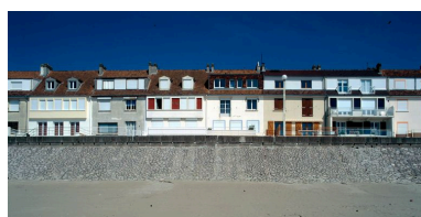
Vue de face de quelques maisons, depuis la plage. Phot. Marie-Laure Monnehay-Vulliet IVR22_20038000490XA
