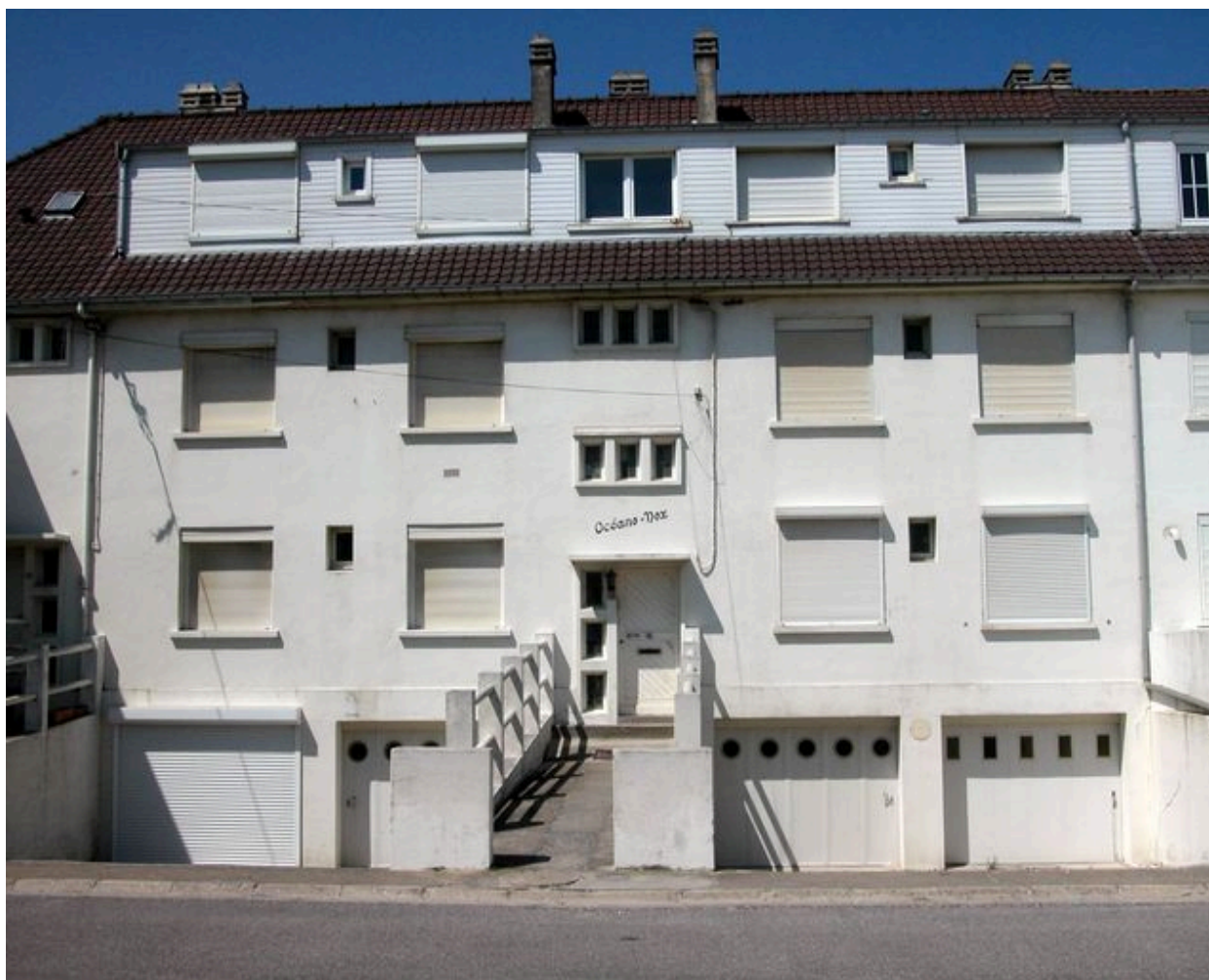
154 boulevard maritime sud (Océano Nox), façade d'entrée.
