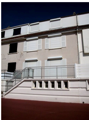
134 boulevard maritime sud, façade sur mer. Phot. Elisabeth Justome
