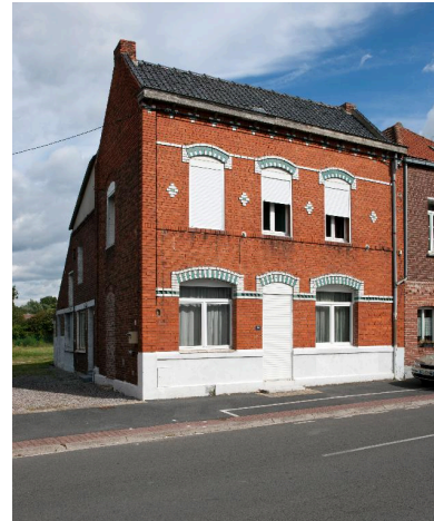
Vue générale d'une maison de bourg, 496 rue du Pont. Phot. Pierre Thibaut IVR31_20125902196NUCA
