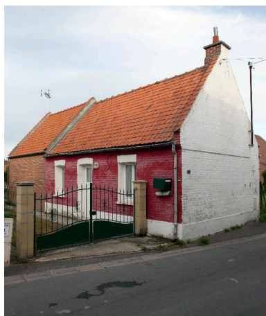
Vue générale d'une maison 78 rue de la Vieille-Eglise. Phot. Pierre Thibaut
