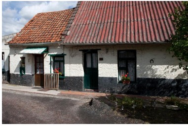
Les communs d'une ferme élémentaire 297, 299 rue des Frères-Sans Phot. Pierre Thibaut IVR31_20125902190NUCA
