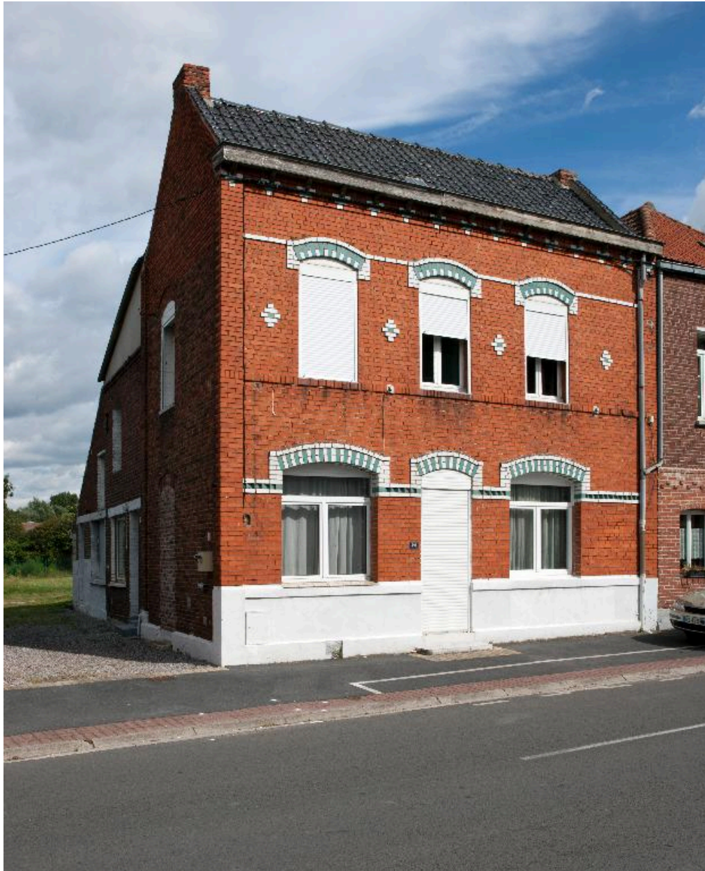
Vue générale d'une maison de bourg, 496 rue du Pont.
