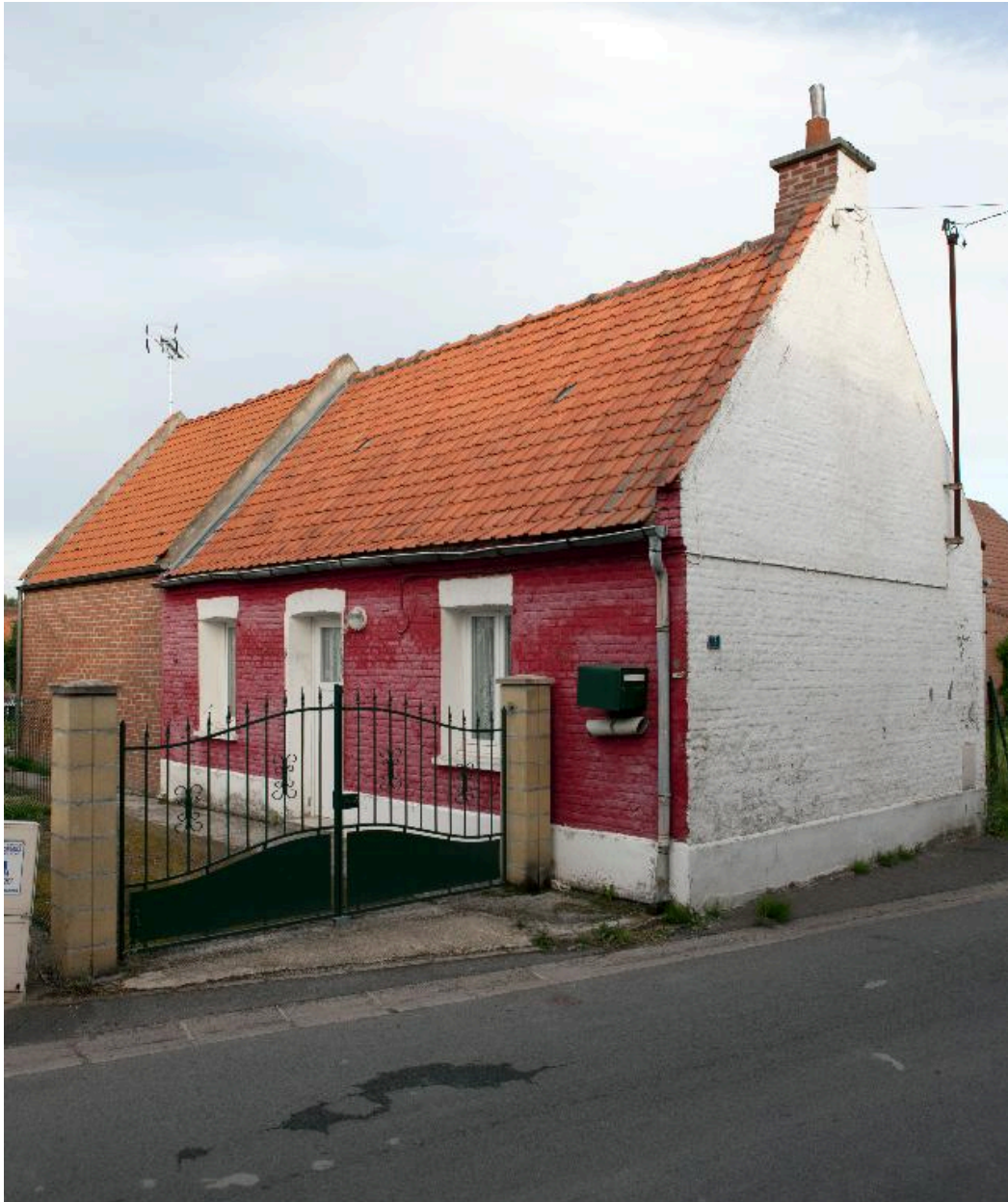
Vue générale d'une maison 78 rue de la Vieille-Eglise.
