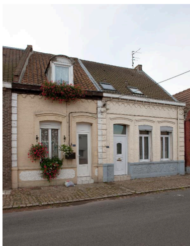
Vue générale de deux maisons élémentaires 61-63 rue René-Caby.
