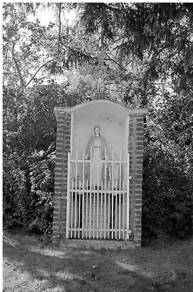
Vue générale. Phot. Xavier-Philippe Guiochon IVR22_19970201653Z
