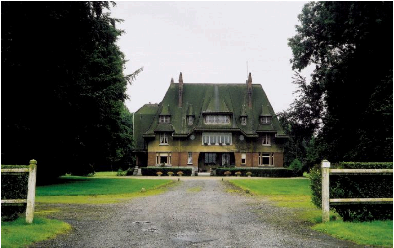
Façade principale nord.
