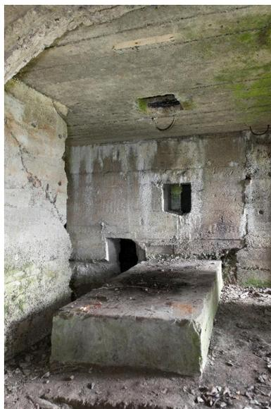
Salle sud : Massif bétonné du moteur diesel. Au fond, deux des quatre ouvertures débouchant salle nord (passage de tuyaux ?). On remarque les anneaux métalliques au plafond et la cheminée d'évacuation des fumées
