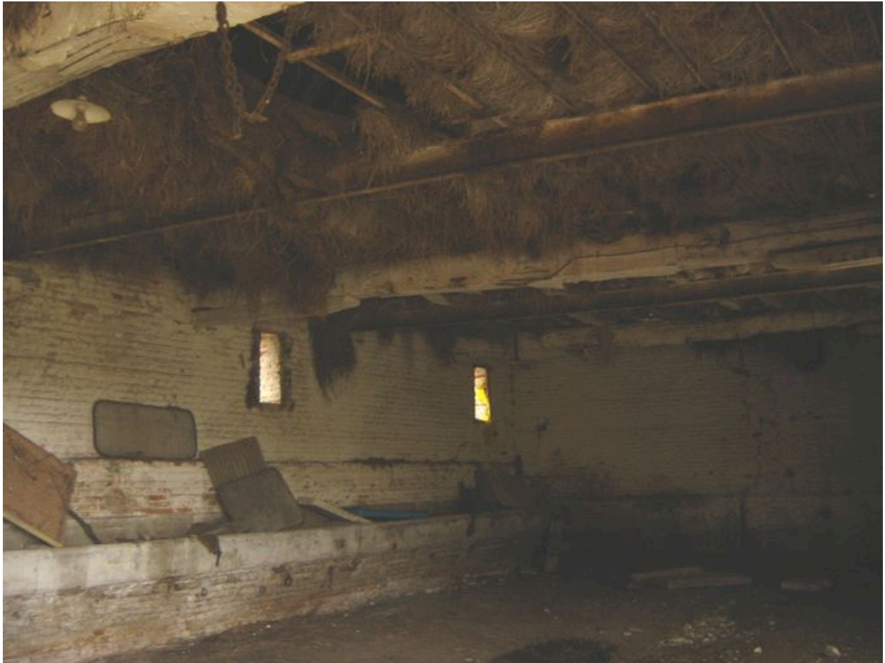
Vue intérieure de la partie étable.
