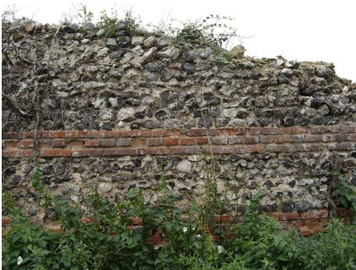
Vue du mur de clôture dans la rue menant à Tilloy.
