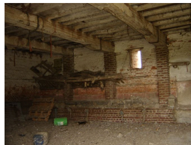
Vue intérieure de la partie écurie. Phot. Inès Guérin IVR22_20078005105NUCA
