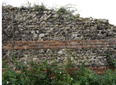
Vue du mur de clôture dans la rue menant à Tilloy. Phot. Inès Guérin IVR22_20078005107NUCA
