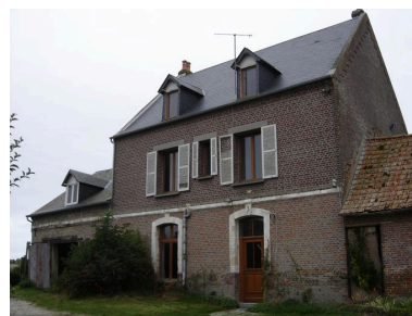
Vue du logis. Phot. Inès Guérin IVR22_20078005097NUCA
