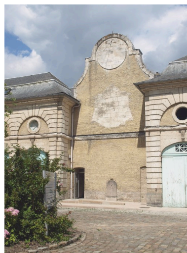
Vue sur le revers du fronton situé au nord Phot. Maya Bennani IVR31_20106202520NUCA
