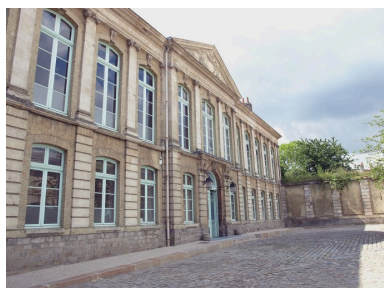
Vue sur le bâtiment principal Phot. Maya Bennani IVR31_20106202513NUCA
