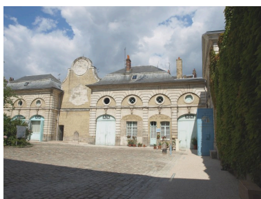
Vue sur les bâtiments donnant sur la rue des tribunaux, vus depuis la cour Phot. Maya Bennani IVR31_20106202522NUCA
