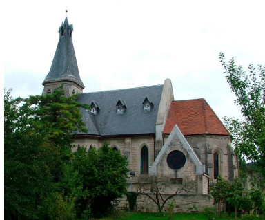
Vue de situation, depuis le sud. Phot. Frédéric Fournis IVR22_20040202731NUC1A
