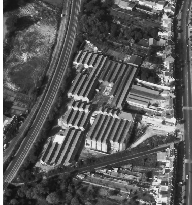
Vue aérienne, flanc est. Phot. Phot'R IVR22_19908001823P
