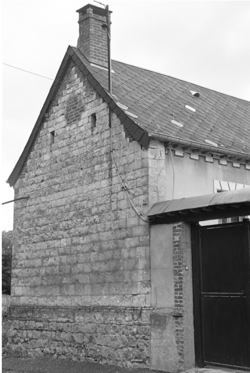
Le pignon ouest du logis fermant la cour au nord.
