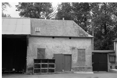
Logis formant le côté ouest de la cour, vue de l'est.
