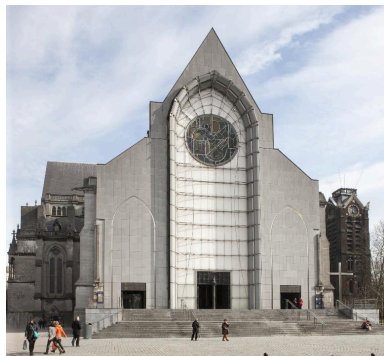
Elévation de la façade. Phot. Pierre Thibaut IVR31_20155900116NUCA
