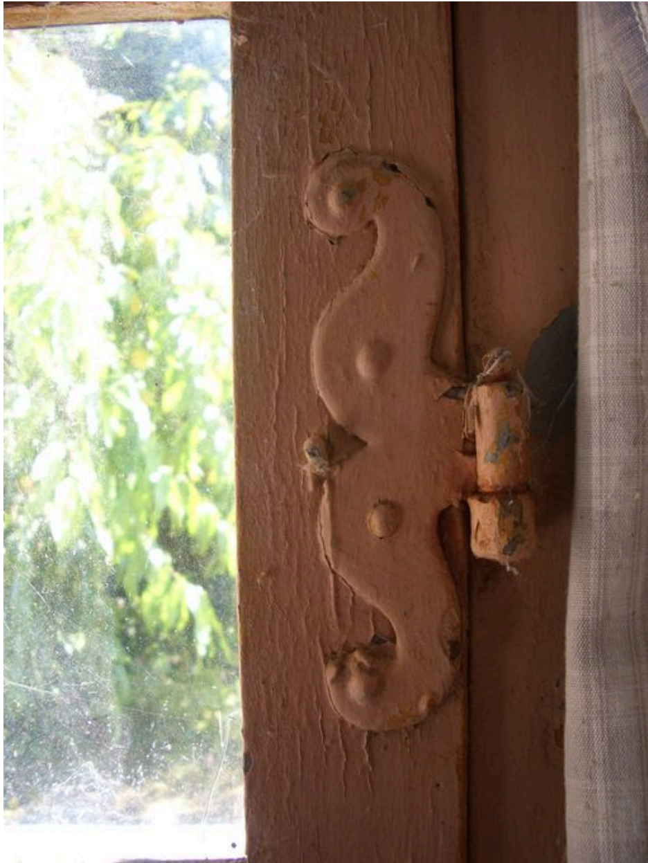
Détail de la ferrure de fenêtre à profil dit de vipère ou de moustache.
