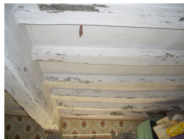
Vue du plafond de la chambre. Phot. Inès Guérin IVR22_20068005229NUCA
