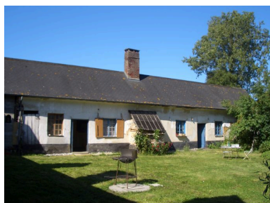
Vue du logis. Phot. Inès Guérin IVR22_20068005217NUCA
