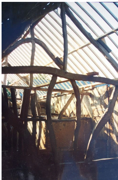
Vue de la charpente des étables. Phot. Inès Guérin IVR22_20068005256NUCAB
