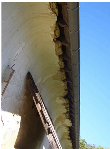
Vue de la corniche arrondie, dite voûte. Phot. Inès Guérin IVR22_20068005218NUCA
