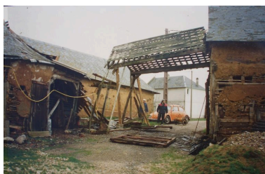
Vue du corps de passage en cours de démantèlement. Phot. Inès Guérin IVR22_20068005251NUCAB
