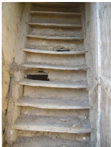
Vue de l'escalier de meunier menant aux combles. Phot. Inès Guérin IVR22_20068005227NUCA
