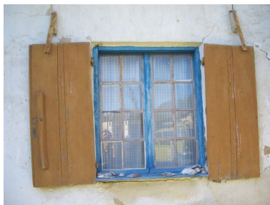
Vue d'un contrevent avec système d'attache à tourniquet. Phot. Inès Guérin IVR22_20068005223NUCA
