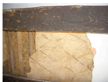
Vue détaillée du plafond de la salle avec système de stries pour une meilleure adhérence de l'enduit. Phot. Inès Guérin IVR22_20068005261NUCA
