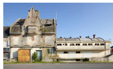
Vue générale. L'ancien hôtel Sheffield et l'extension de la coopérative agricole. Phot. Hubert Bouvet IVR32_20196200884NUC4A
