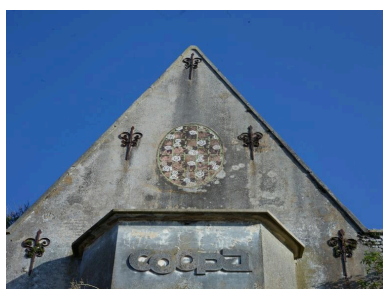
Vue de détail du décor de mosaïque du pignon de l'ancien hôtel représentant un motif floral et inscription relative à la nouvelle fonction de l'édifice. Phot. Hubert Bouvet IVR32_20196200886NUC4A
