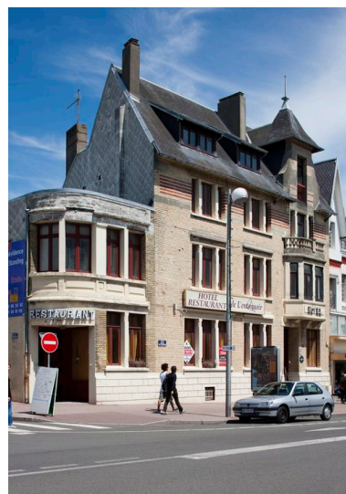
L'hôtel-restaurant de l'Entonnoir, 31 avenue Francis-Tattegrain. Vue prise en 2013 avant sa transformation. Phot. Hubert Bouvet IVR31_20136200109NUCA
