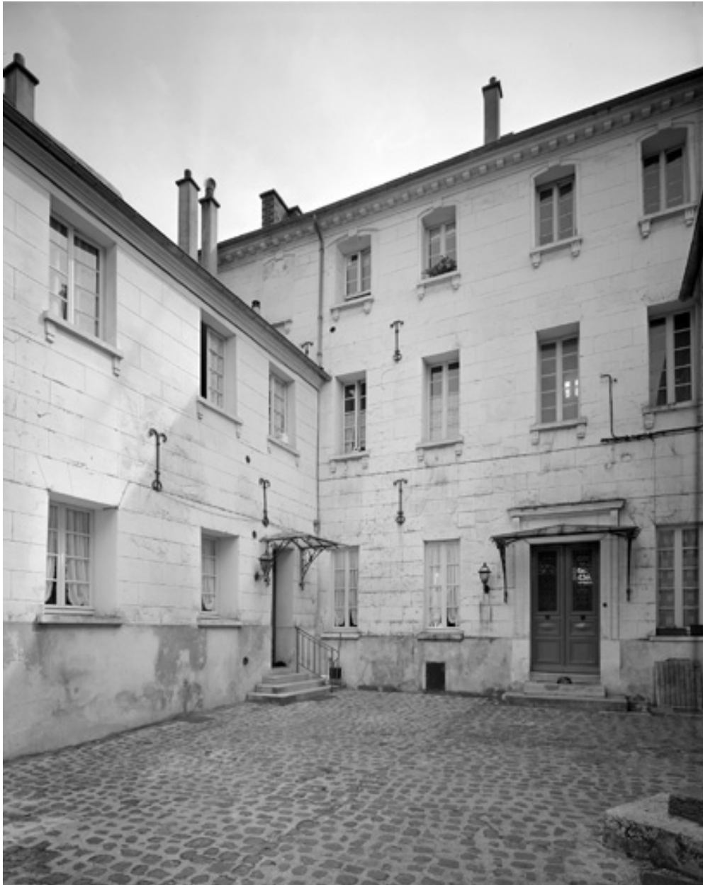
Elévation sur la cour, avec l'aile en retour gauche.
