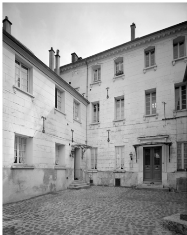
Elévation sur la cour, avec l'aile en retour gauche. Phot. Thierry Lefébure IVR22_19930200917V
