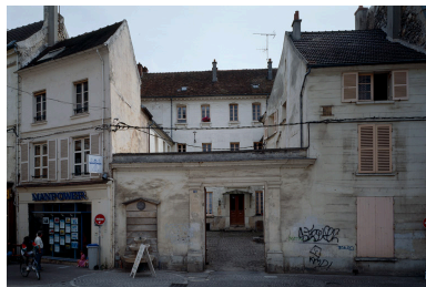
Vue d'ensemble depuis la rue. Phot. Thierry Lefébure IVR22_19930200958XA
