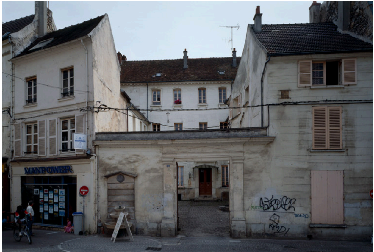
Vue d'ensemble depuis la rue.
