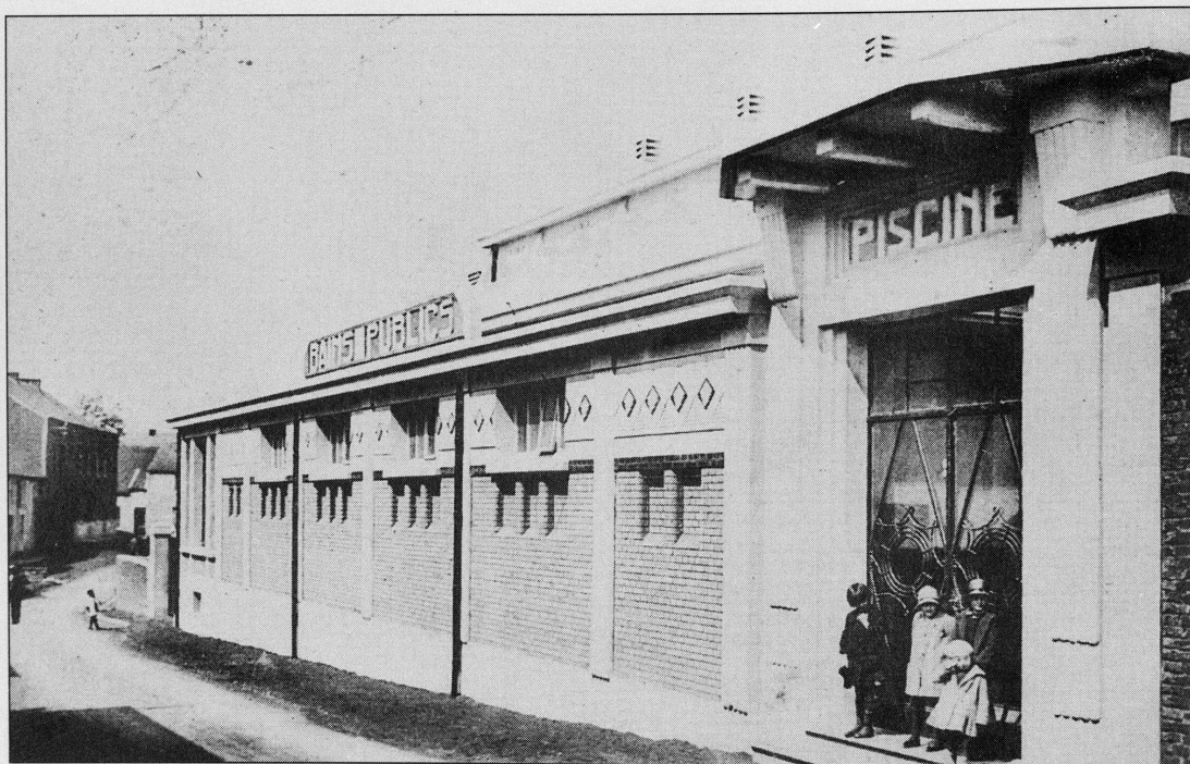
La piscine de la rue des Ecoles (devenue rue de Lambaréné) fut également construite par A. Danis ; c'est une des plus anciennes du département, construite dans le style Art-Déco.
