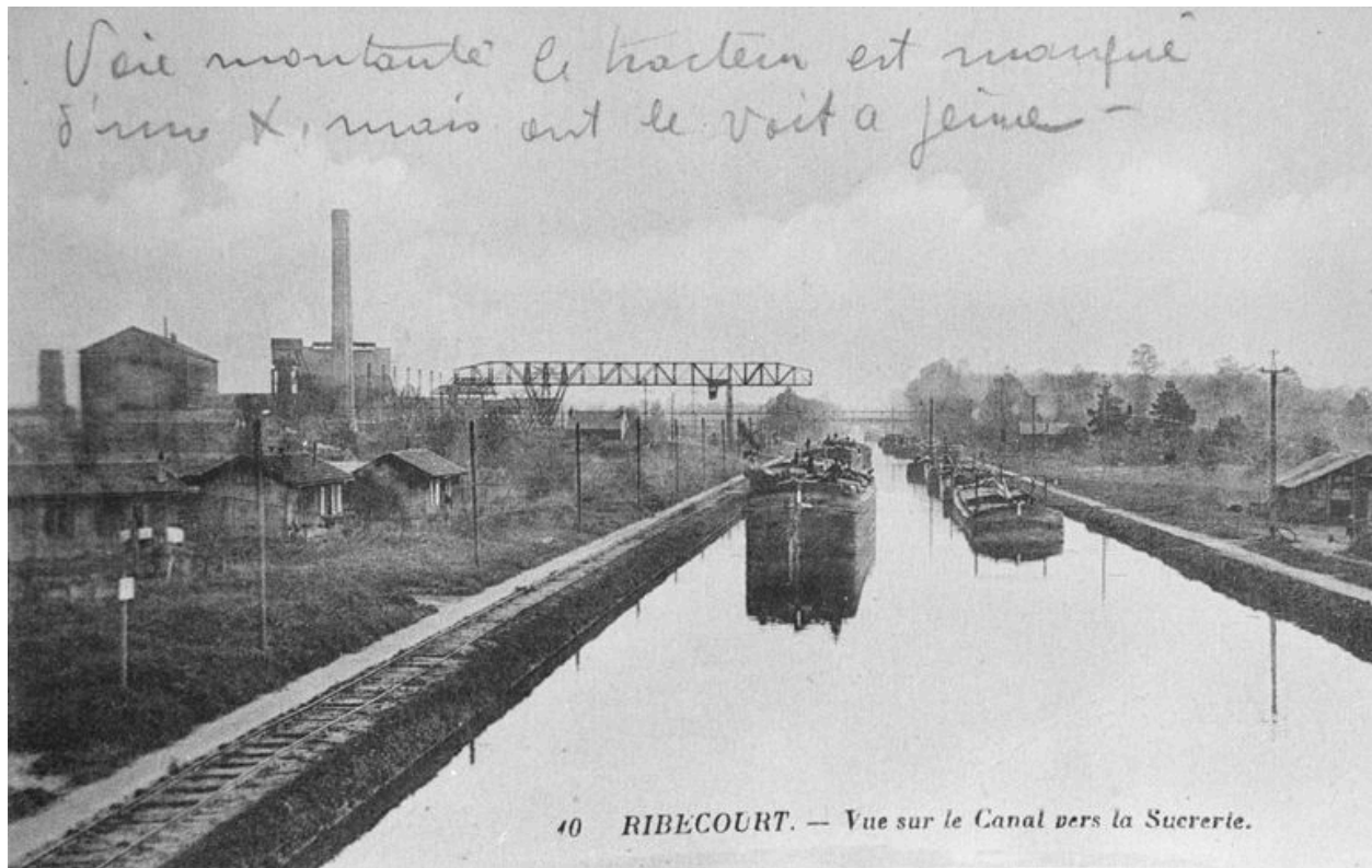
Vue de l'usine depuis le canal de l'Oise, vers 1930 (AP).
