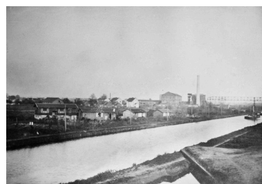
Vue de l'usine depuis le canal de l'Oise, vers 1930 (AP).
