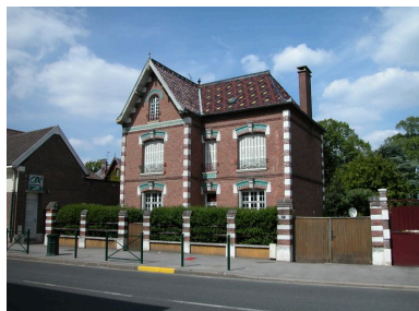
Vue d'ensemble depuis le quai du Romerel. Phot. Elisabeth Justome IVR22_20058002861NUCA
