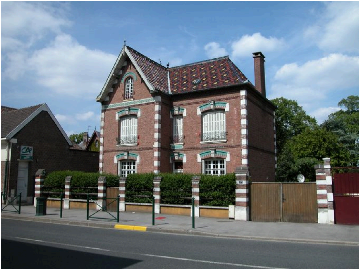
Vue d'ensemble depuis le quai du Romerel.
