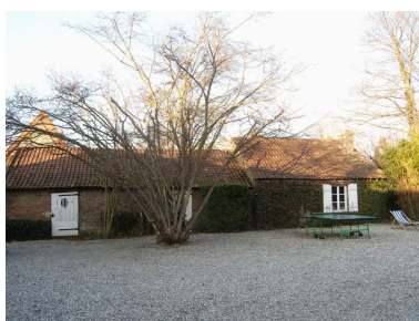
Vue des dépendances situées au nord de la propriété (écuries, étables et fournil). Phot. Inès Guérin IVR22_20058005316NUCA
