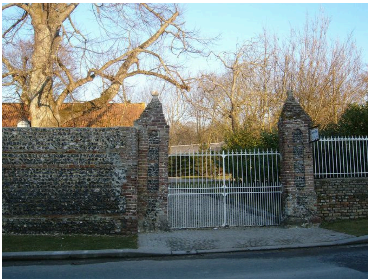
Vue du mur de clôture muni de son portail à deux piliers.
