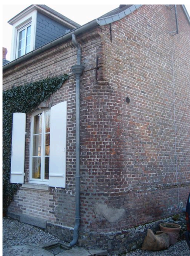
Vue de l'angle nord arrondi de la maison avec encorbellement. Phot. Inès Guérin IVR22_20058005314NUCA
