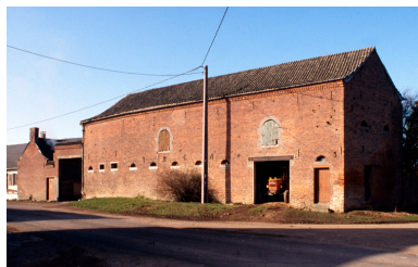
Vue d'ensemble de l'élévation sur rue, depuis le nord-est. Phot. Christiane Riboulleau IVR22_19910202715ZA
