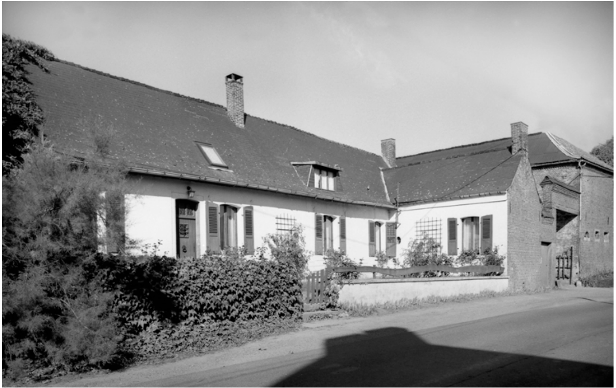
Vue d'ensemble de la façade du logis.
