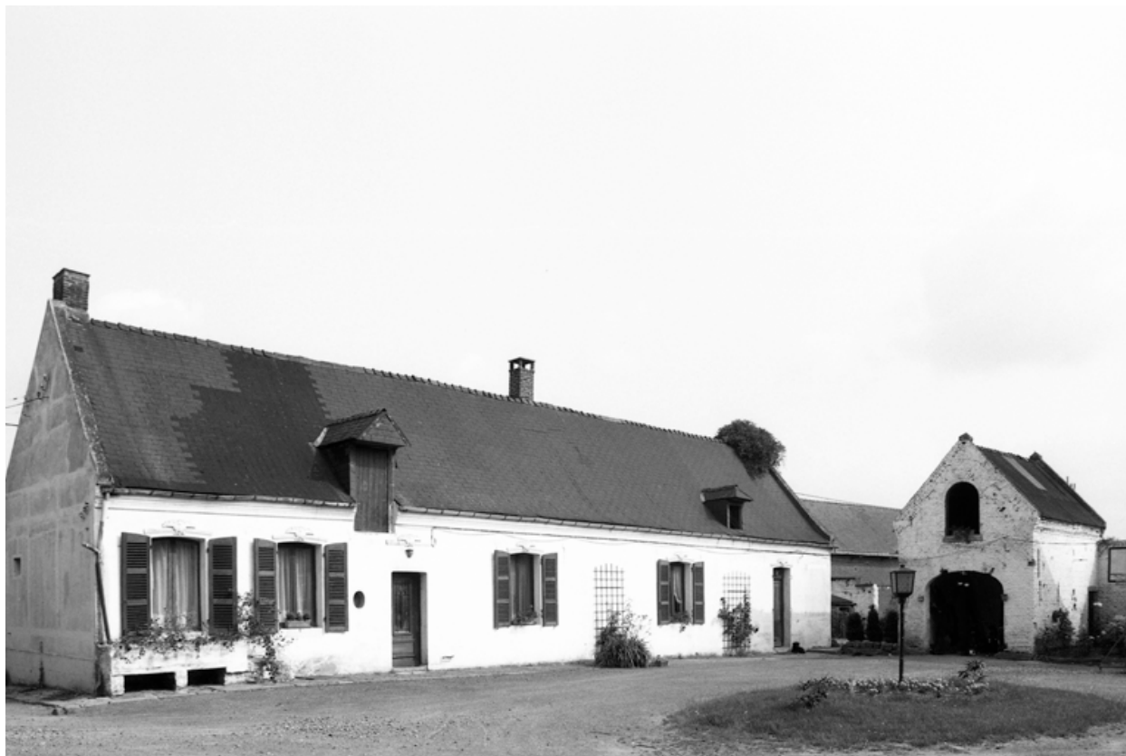
Vue d'ensemble des élévations sur cour du logis et de la remise, depuis le nord-ouest.
