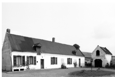
Vue d'ensemble des élévations sur cour du logis et de la remise, depuis le nord-ouest. Phot. Thierry Lefébure IVR22_19920201282Z
