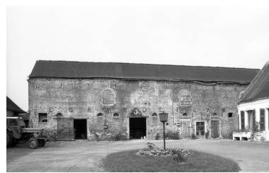
Elévation sur cour de l'étable à chevaux. Phot. Thierry Lefébure IVR22_19920201280Z
