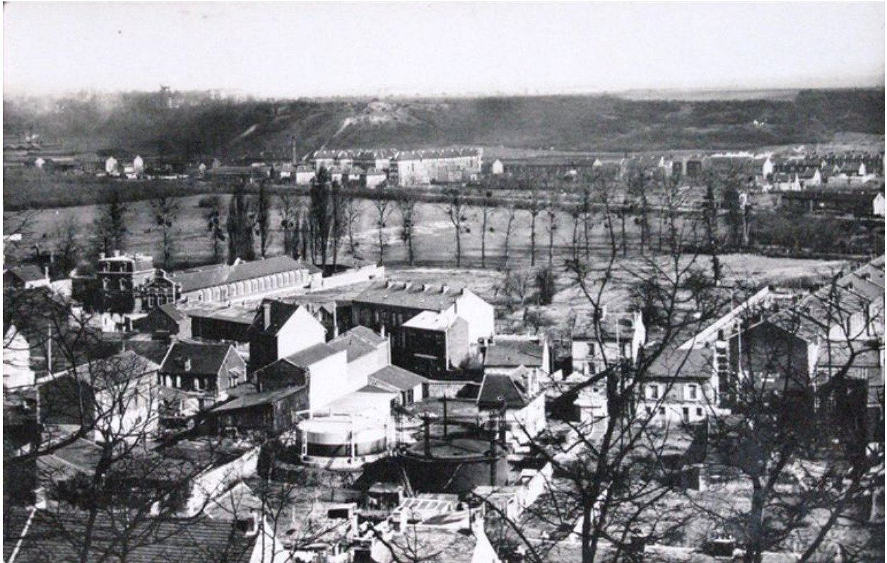
Les deux cuves de l'usine à gaz vers 1950 (?); (AC Montataire).
