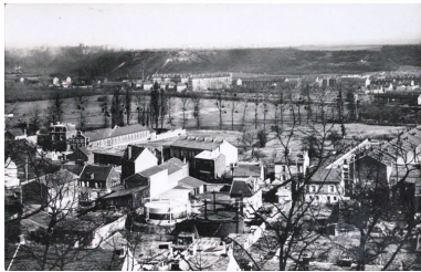
Les deux cuves de l'usine à gaz vers 1950 (?) ; (AC Montataire). Phot. Clarisse Lorieux IVR22_20076005497NUCAB
