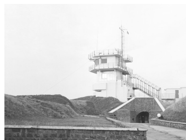
Vue d' ensemble sur cour intérieure. Phot. Michèle Rougier IVR31_19966200708X
