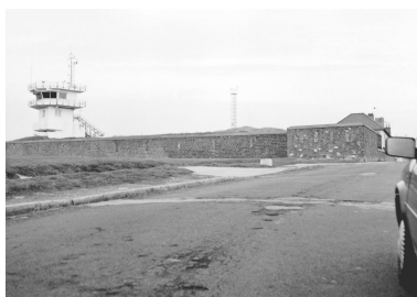
Façade partielle ouest. Phot. Michèle Rougier IVR31_19966200707X
