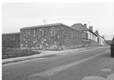
Vue d' angle sud est. Phot. Michèle Rougier IVR31_19966200706X
