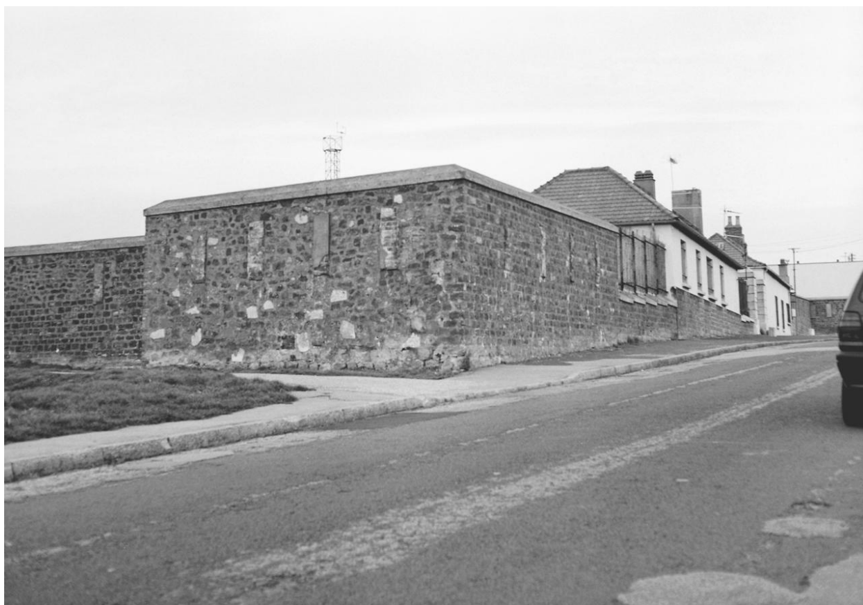
Vue d' angle sud est.
