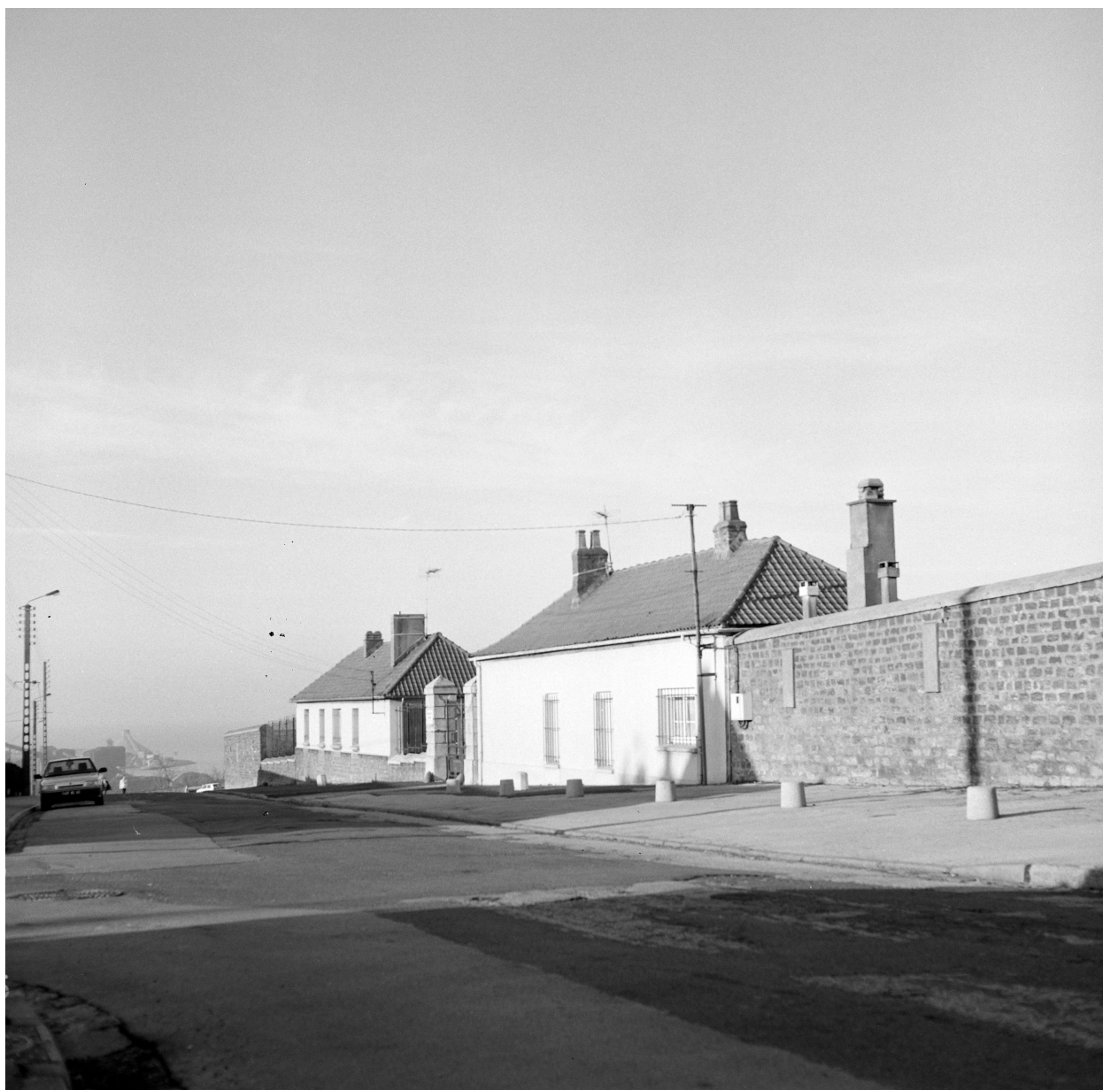
Vue générale sur entrée.
