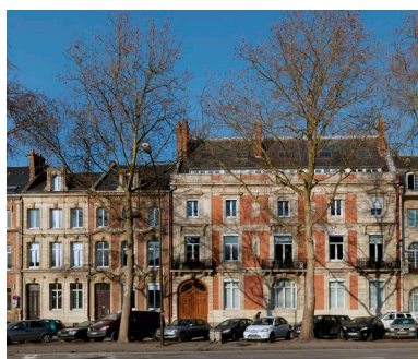
Vue de situation, maisons à gauche de l'image. Phot. Thierry Lefébure IVR22_20128000217NUCA
