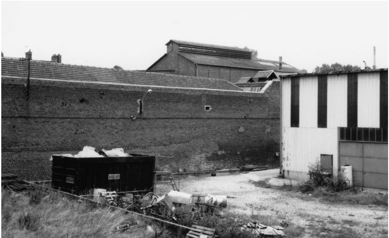
Vue du mur de clôture depuis l'ouest, les salles des machines à l'arrière-plan.
