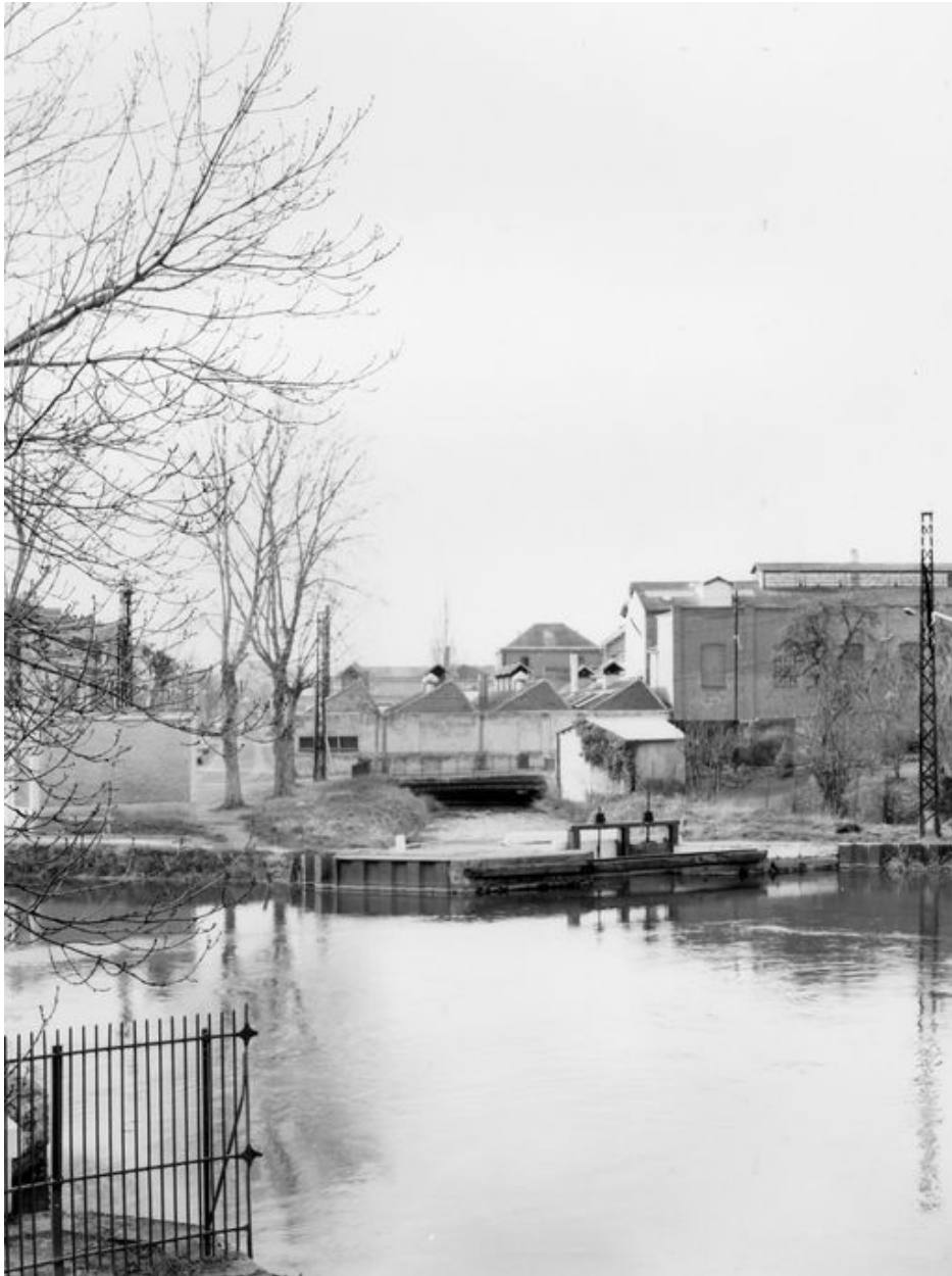
Les ateliers d'apprêts et les ateliers de teinture, vus depuis l'est, le vannage et le canal des Teinturiers au premier plan.
