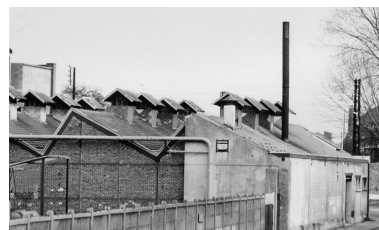
Les ateliers de teinture, vus depuis le sud-ouest. Phot. Thierry Lefébure IVR22_19888000317Z
