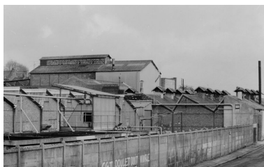
Les ateliers de teinture et les salles des machines, vus depuis le sud-ouest. Phot. Thierry Lefébure IVR22_19888000314Z
