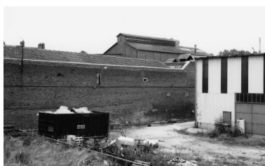
Vue du mur de clôture depuis l'ouest, les salles des machines à l'arrière-plan. Phot. Thierry Lefébure
