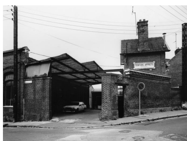
La conciergerie et l'entrée de l'usine. Phot. Thierry Lefébure IVR22_19888000773V
