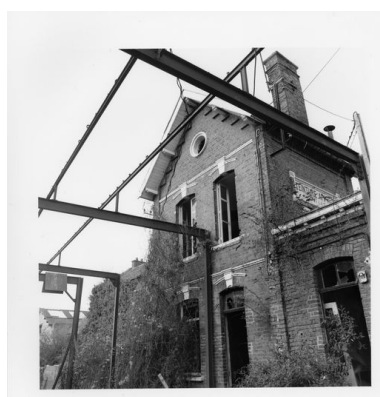
La conciergerie, façade sud sur la cour. Phot. Thierry Lefébure IVR22_19998000483X
