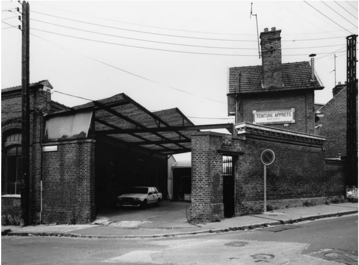
La conciergerie et l'entrée de l'usine.
