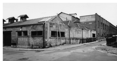
Les ateliers d'apprêts et les ateliers de teinture au premier plan, vus depuis le sud-est. Phot. Thierry Lefébure IVR22_19888000772V
