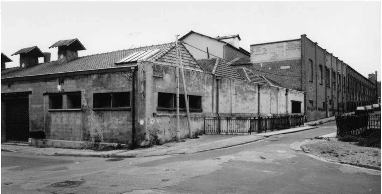
Les ateliers d'apprêts et les ateliers de teinture au premier plan, vus depuis le sud-est.
