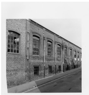
Les anciens ateliers d'apprêts vus depuis le sud-est. Phot. Thierry Lefébure IVR22_19998000472X
