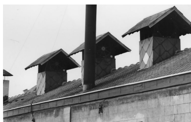
Les ateliers de teinture, détail des cheminées d'aération. Phot. Thierry Lefébure IVR22_19888000329Z
