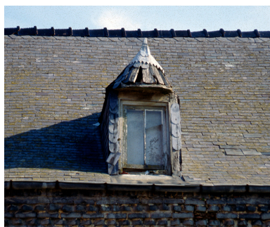
Lucarne. Ferme, 3 rue de Verdun. Phot. Martine Plouvier IVR22_19900202816ZA
