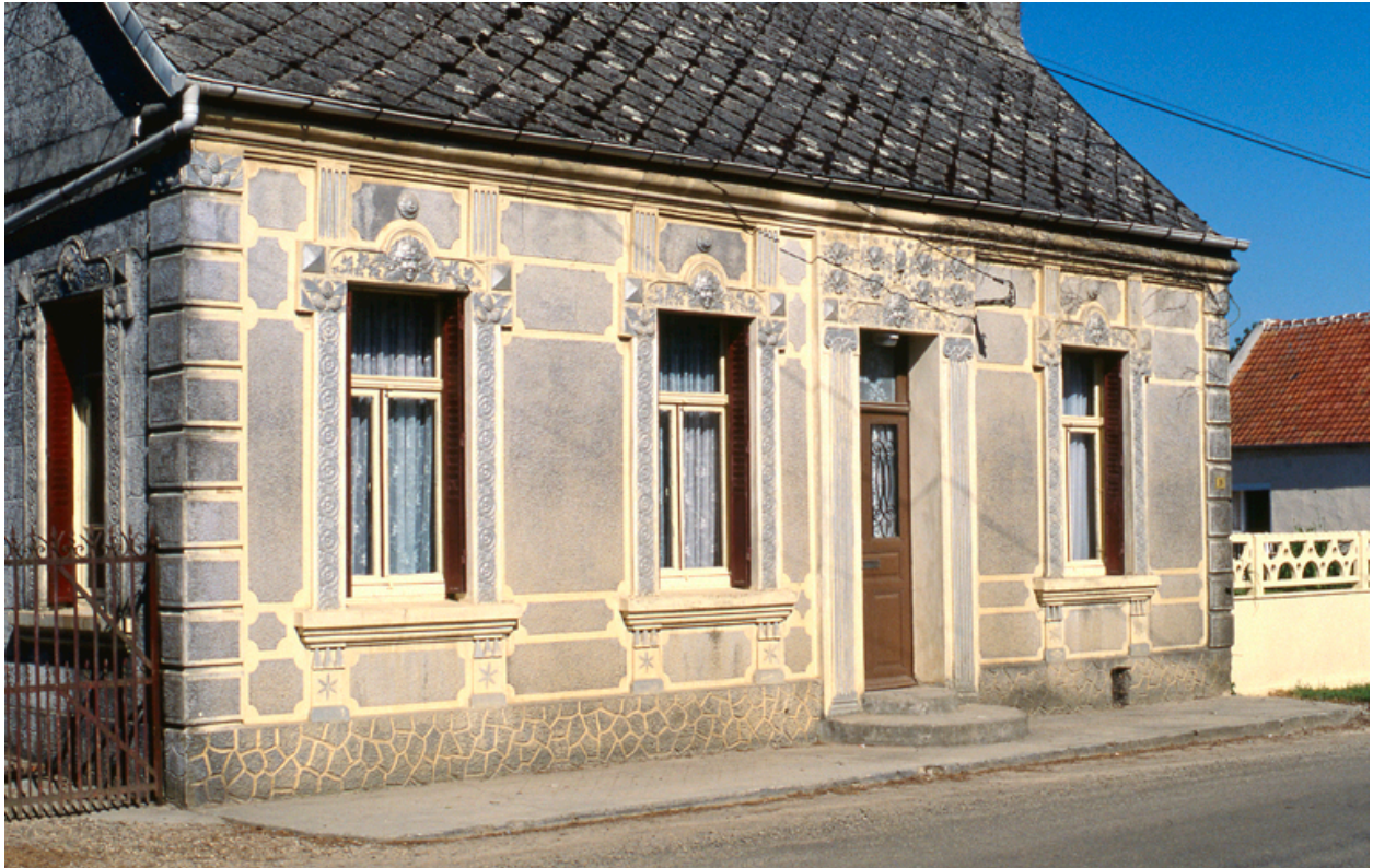
Maison, 20 rue de Verdun.
