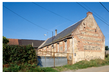
Ferme, 5 rue Stievet. Phot. Martine Plouvier IVR22_19900202815ZA
