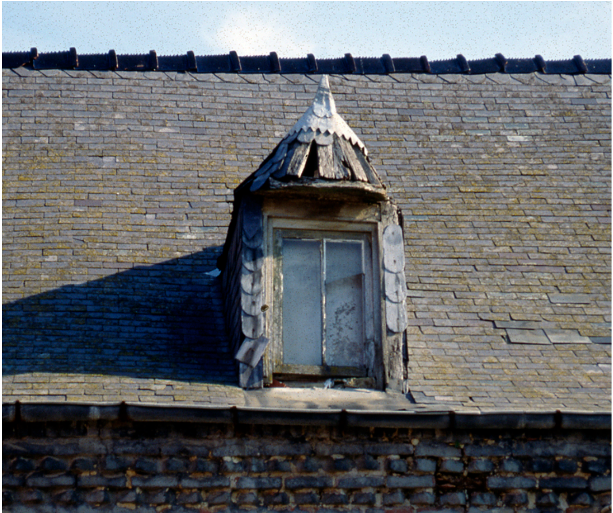
Lucarne. Ferme, 3 rue de Verdun.
