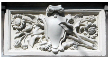
Détail d'un panneau d'allège. Phot. Elisabeth Justome IVR22_20058003792NUCA
