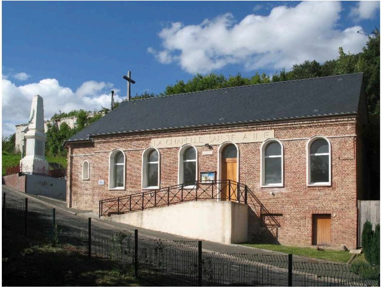
Façade sur de l'ancienne école des garçons, devenue chapelle Sainte-Anne.
