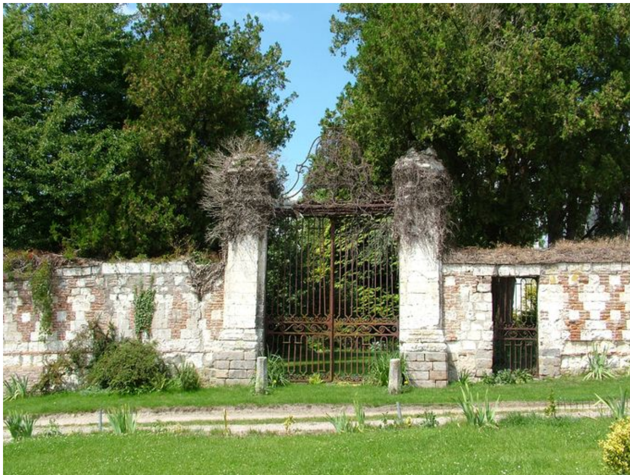
Vue du portail de l'ancien château, 18e siècle.
