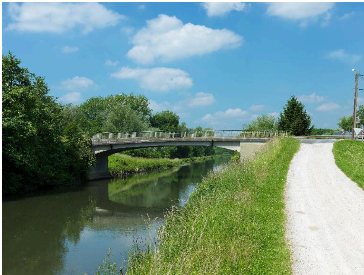
Le pont sur la Somme, reconstruit en 1949.
