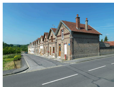
Vue d'ensemble de la cité Anthime Gigaut, une des deux cités Neuves. Phot. Thierry Lefébure IVR22_20128000288NUC2A
