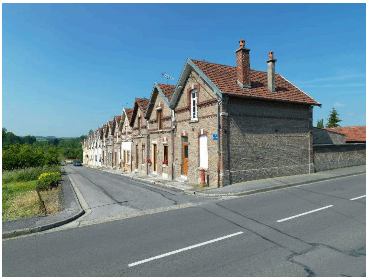
Vue d'ensemble de la cité Anthime Gigaut, une des deux cités Neuves.
