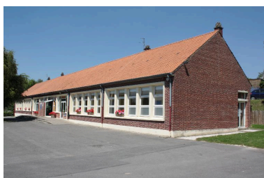
Ancien groupe scolaire des Moulins-Bleus, actuelle mairie de l'Etoile Phot. Bertrand Fournier IVR22_20128005159NUCA
