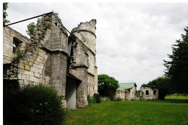
Vestiges de la porterie, de la chapelle et des bâtiments du prieuré de Moréaucourt. Phot. Marie-Laure Monnehay-Vulliet IVR22_20128001085NUC2A
