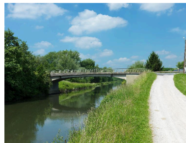
Le pont sur la Somme, reconstruit en 1949. Phot. Thierry Lefébure IVR22_20128000321NUC2A
