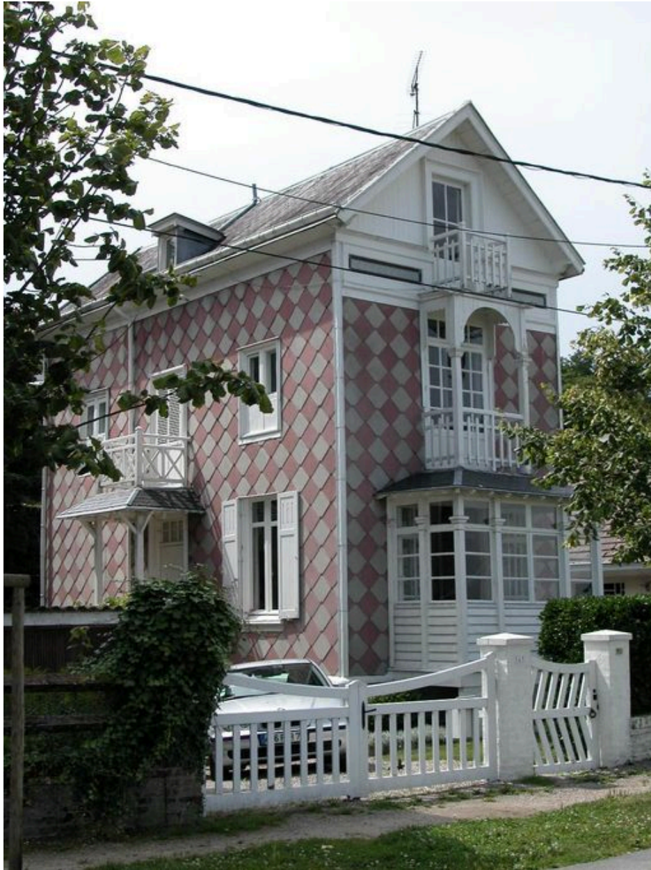
Vue d'ensemble depuis la digue.
