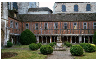
Vue de la galerie méridionale du cloître. Phot. Thierry Lefébure IVR22_19976000447XA
