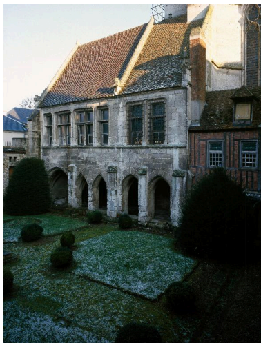
Vue du côté oriental du cloître, avec la salle capitulaire. Phot. Thierry Lefébure IVR22_19996001888VA
