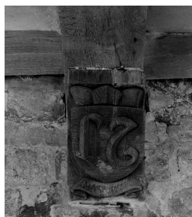
Vue des armoiries sculptées sur la 9e poutre du cloître : initiales LT. Phot. Laurent Jumel IVR22_19966003741X
