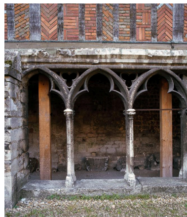
Détail de la galerie sud du cloître. Phot. Thierry Lefébure IVR22_19976000446XA
