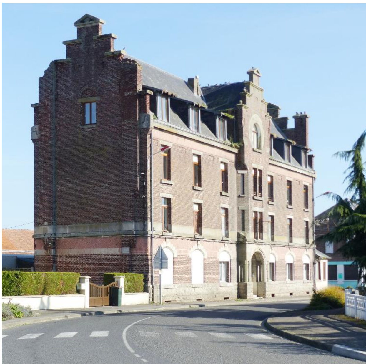
Vue générale, depuis le sud-ouest.
