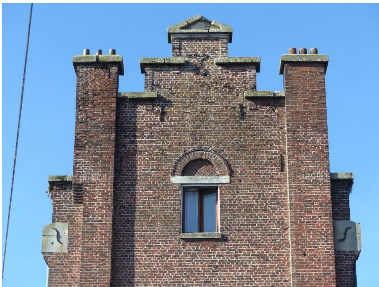
Vue du pignon est.
