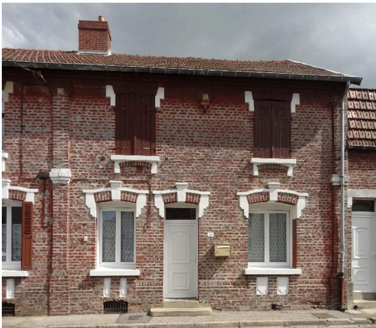
Vue d'un logement.
