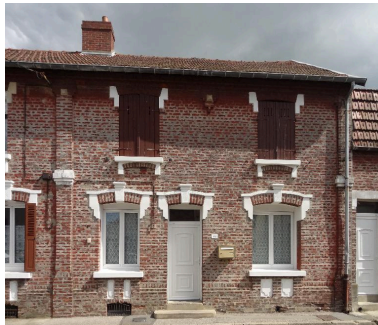
Vue d'un logement.
