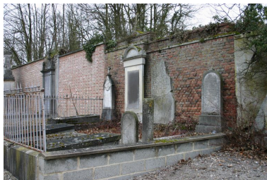
Vue latérale. Phot. Caroline Vincent IVR22_20068000627NUCA
