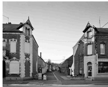
Vue en perspective de la cité, avec les 2 pavillons d'entrée, portant la date de 1921. Phot. Thierry Lefébure IVR22_20020201114V
