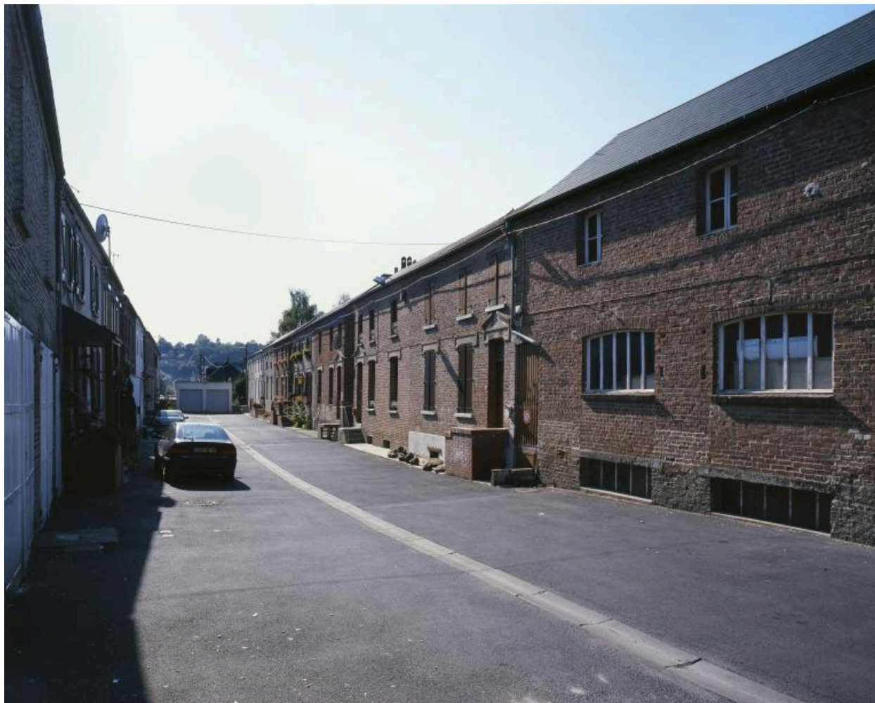
Vue de l'enfilade nord des bâtiments.
