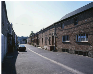
Vue de l'enfilade nord des bâtiments. Phot. Marie-Laure Monnehay-Vulliet IVR22_20000202156VA
