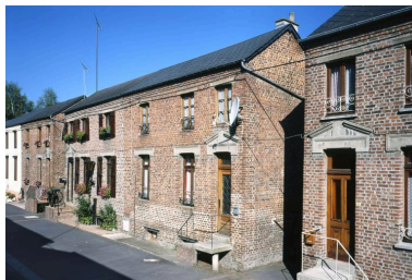
Vue des maisons n°52, 58, 72 et 78 de l'enfilade nord. Phot. Thierry Lefébure IVR22_20000202246XA
